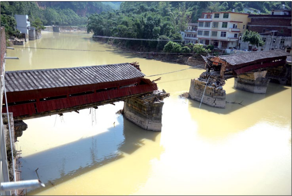
福建泉州市永春县文物保护单位东关桥被洪水冲断( 9 月 15 日 )
