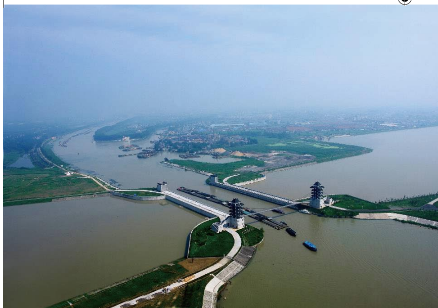
淮安枢纽工程
