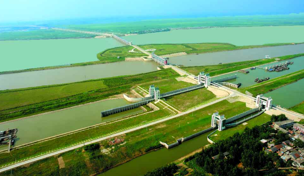
临淮岗洪水控制工程
