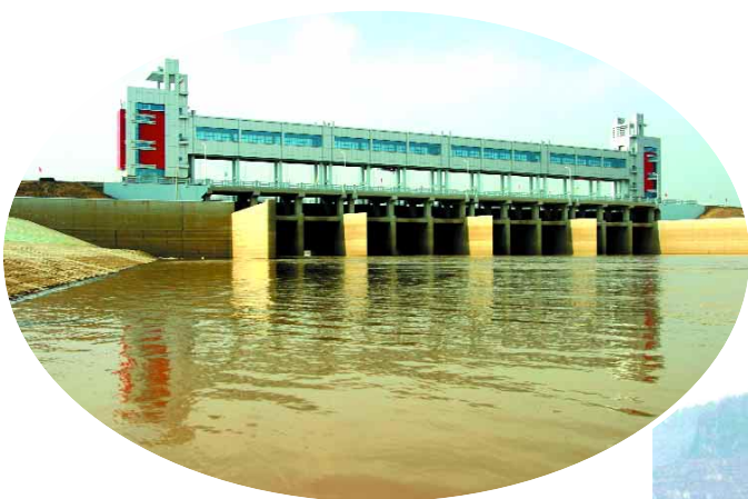
临淮岗12孔深孔闸
