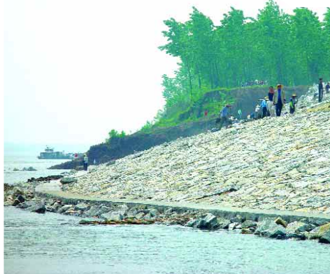
天字一号护坡
