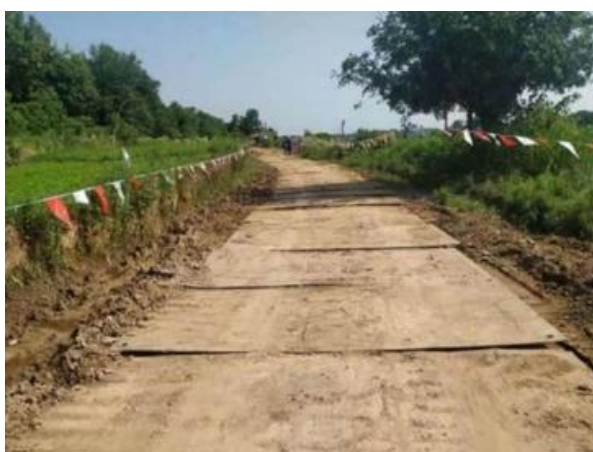
(e) 钢板临时道路
