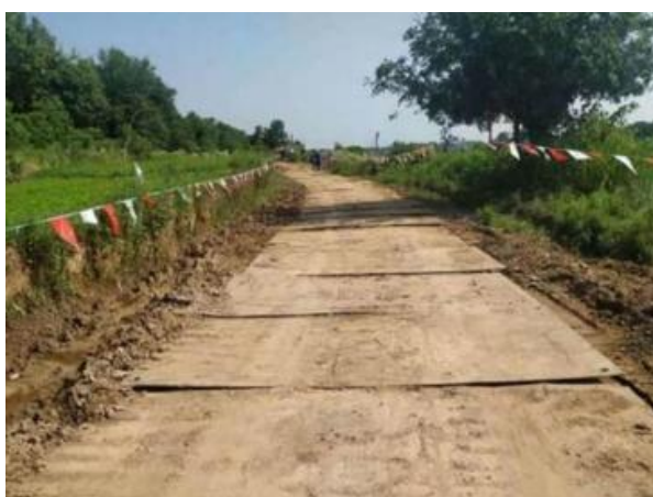
(e) 钢板临时道路
