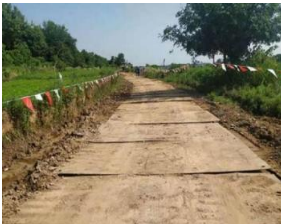
(c) 钢板铺装
