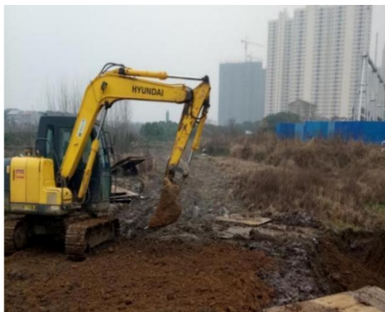
(a) 履带式挖掘机临时道路修建
