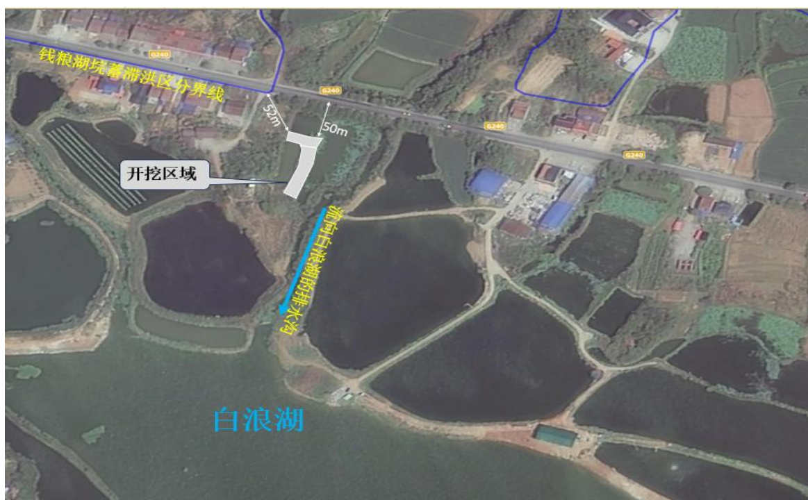
图 8.1.1.1-7 开挖地块位置周围情况
