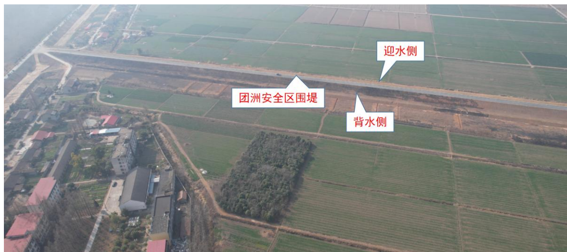
图 3.3.1-4 团洲安全区围堤现场照片
