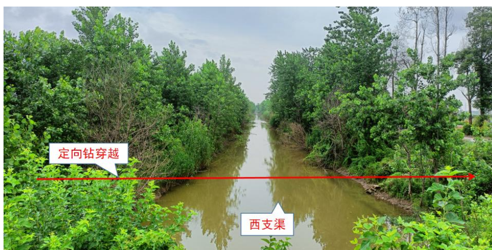
图 2.2.5-13 管道穿越西支渠处现场照片
