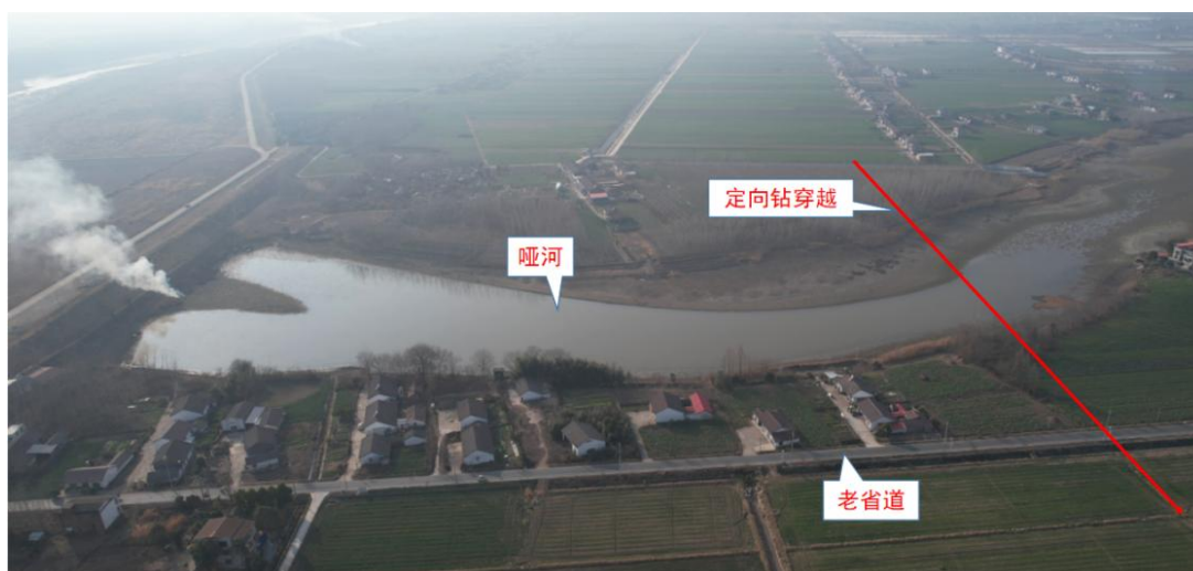
图 2.2.5-12 管道穿越哑河及老省道处现场照片
