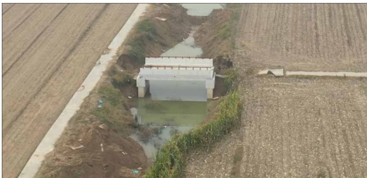
图 3.3-2 永安庄村南桥现状图
