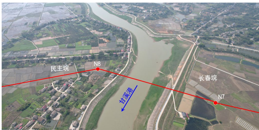
图 3.2-1 跨越甘溪港河位置航拍照片
