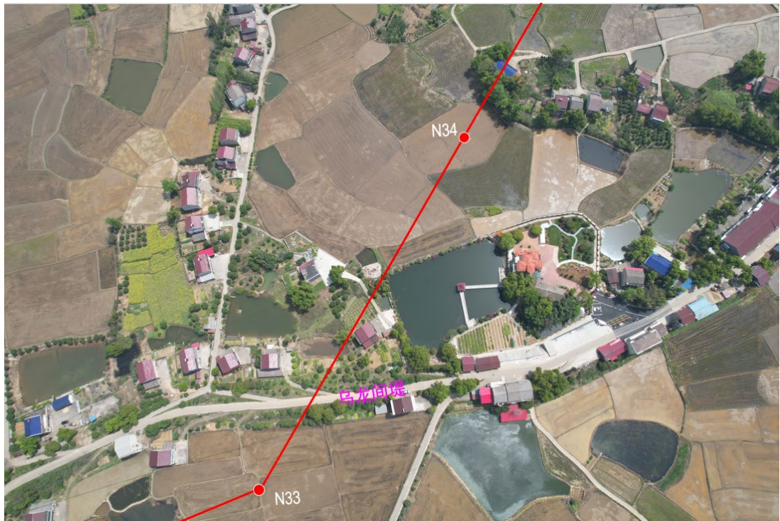
图 3.2-5 跨越乌龙间堤位置航拍照片
