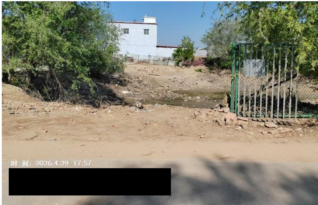
图 2.4-3 弃土场现状图
