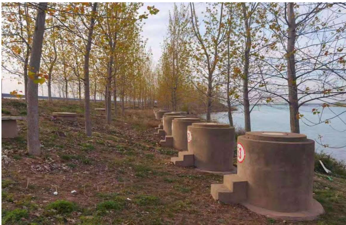
图 3-5 爆破区域现场图片
