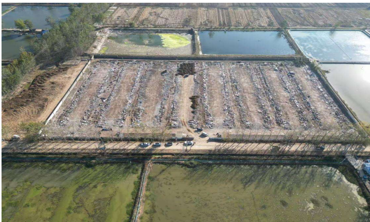
图 2-9 养鸡场场地平整现场图
