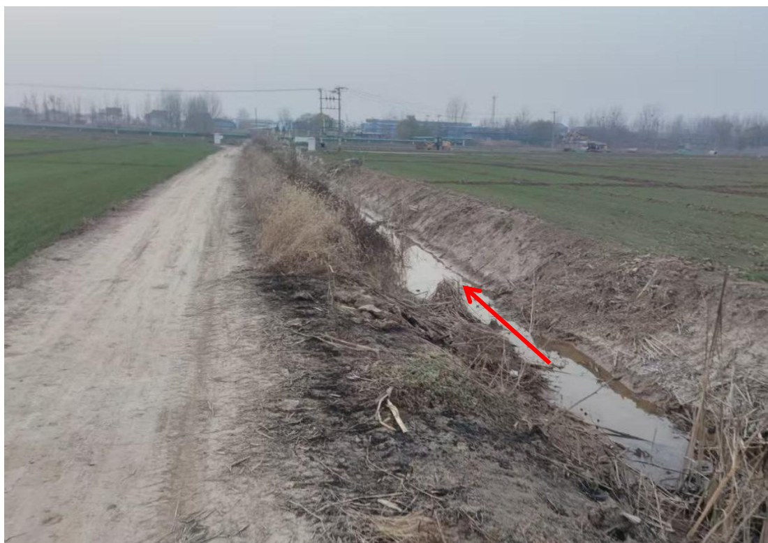
图2-1 占补措施灌排渠道现状
