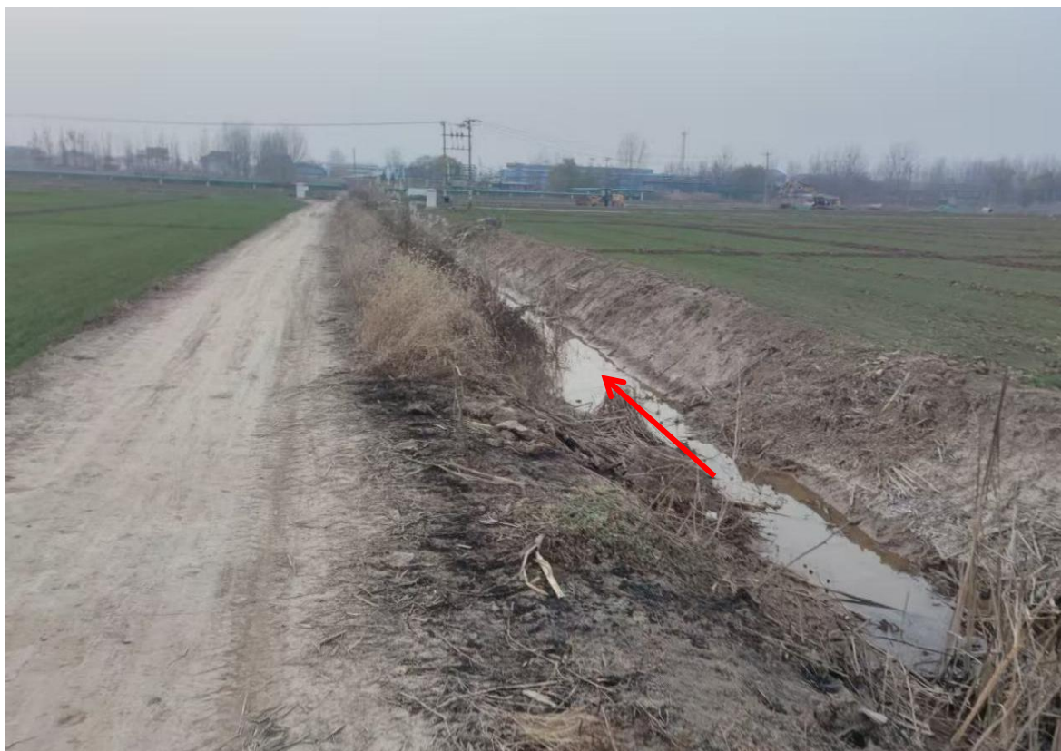
图8.1-1 占补措施灌排渠道现状
