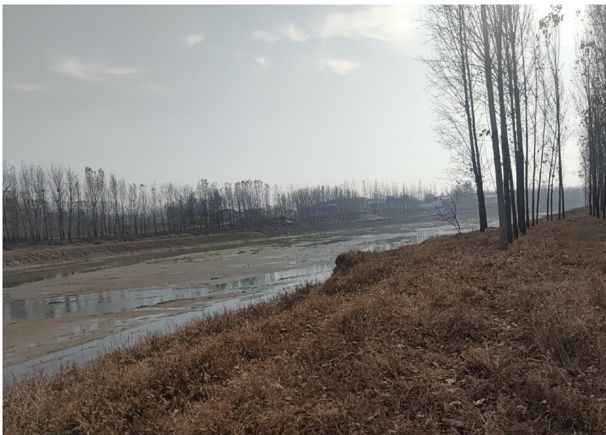
图 3.1-4 小清河交叉位置附近河道主槽和右岸
