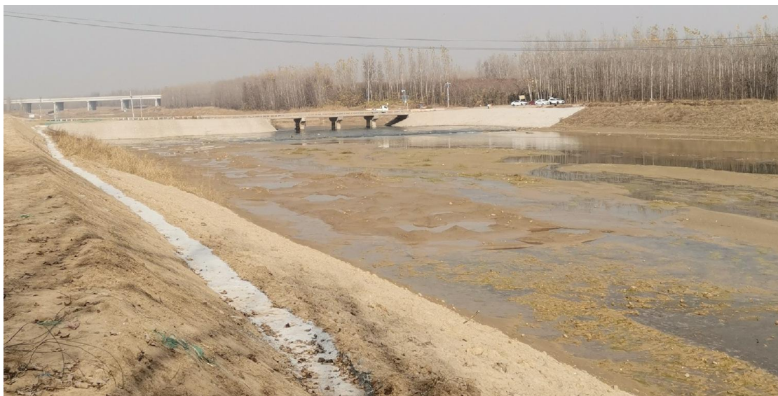
图 3.3-1 北西郭村桥现状图
