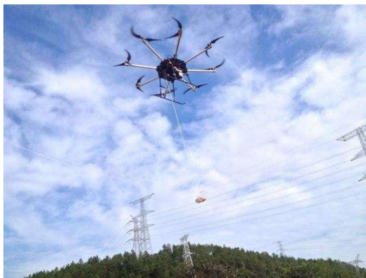
图 2.4-2 无人机放线
