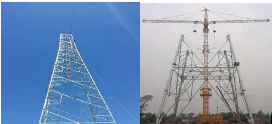
图 2.4-1 悬浮抱杆、落地双平臂抱杆
