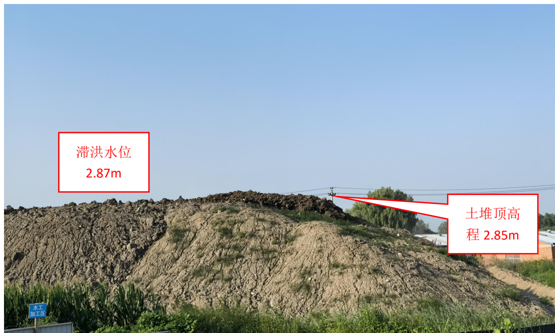
图 6-1 N1 铁塔附近的尔王庄村鱼塘土堆现场照片
