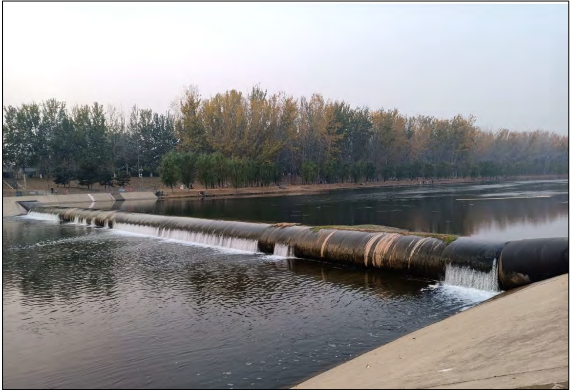
图 3.1-17 水碾庄橡胶坝现状图
