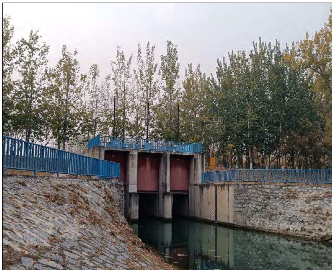
图 3.1-18 水碾屯闸现状图
