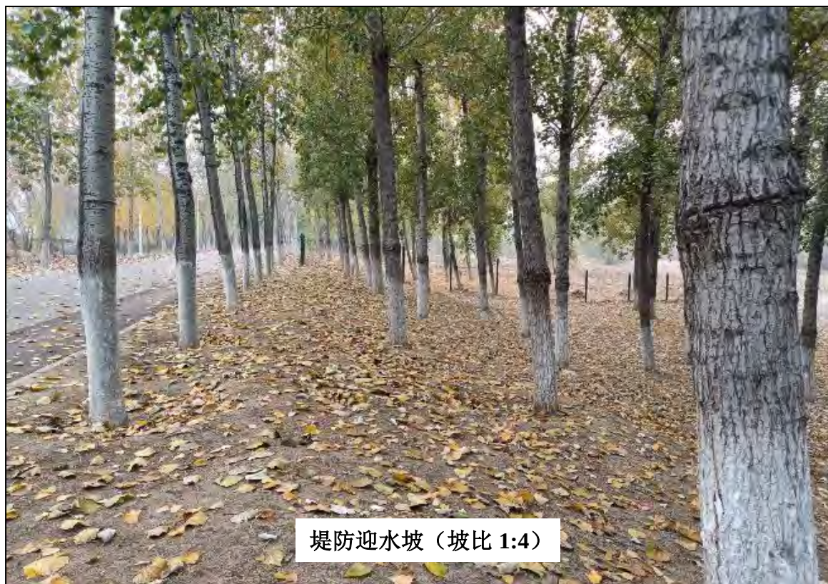
图 3.1-5 堤防迎水坡现状图
