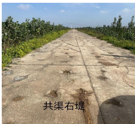
图 3.1-2 工程跨越共渠段右堤现状
