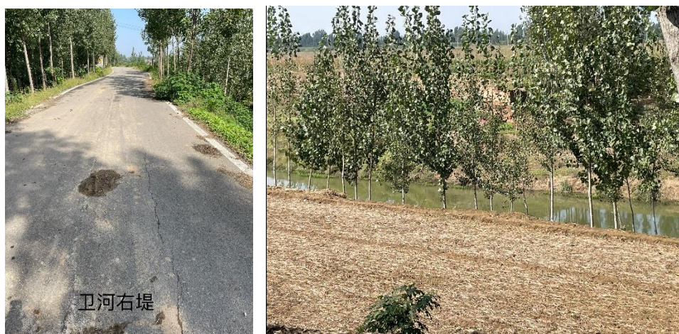
图 2.2.2-14 高压线跨越卫河及右堤
