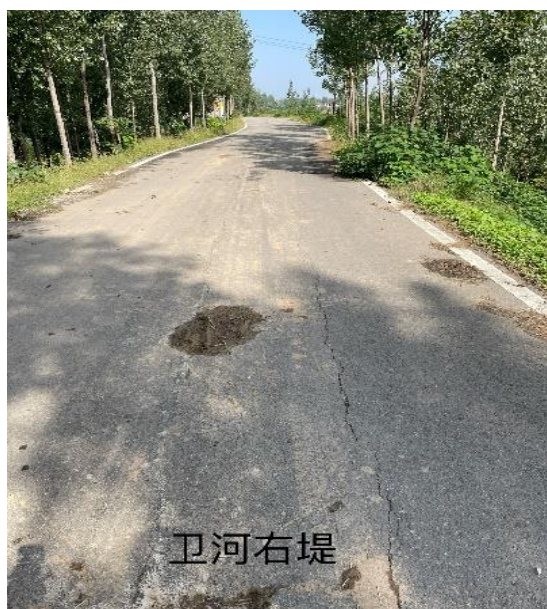
图 3.1-3 工程跨越卫河右堤现状
