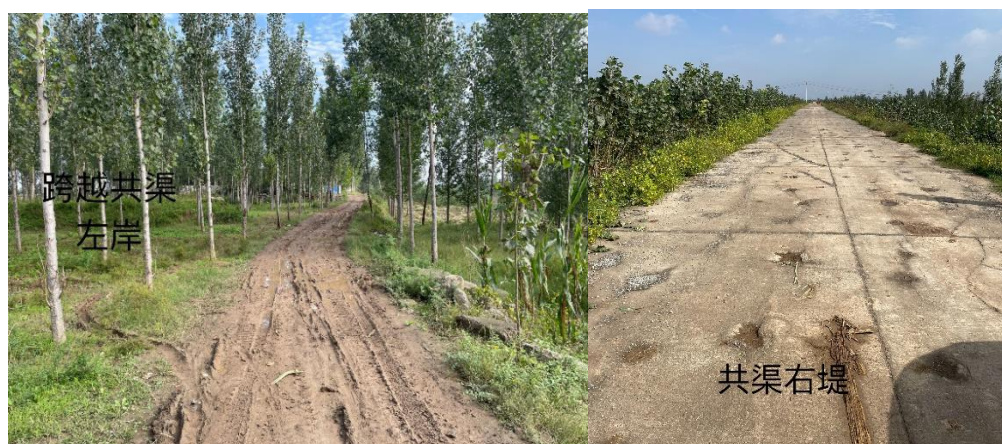
图 2.2.2-11 高压线跨越共渠左、右岸现场照片
