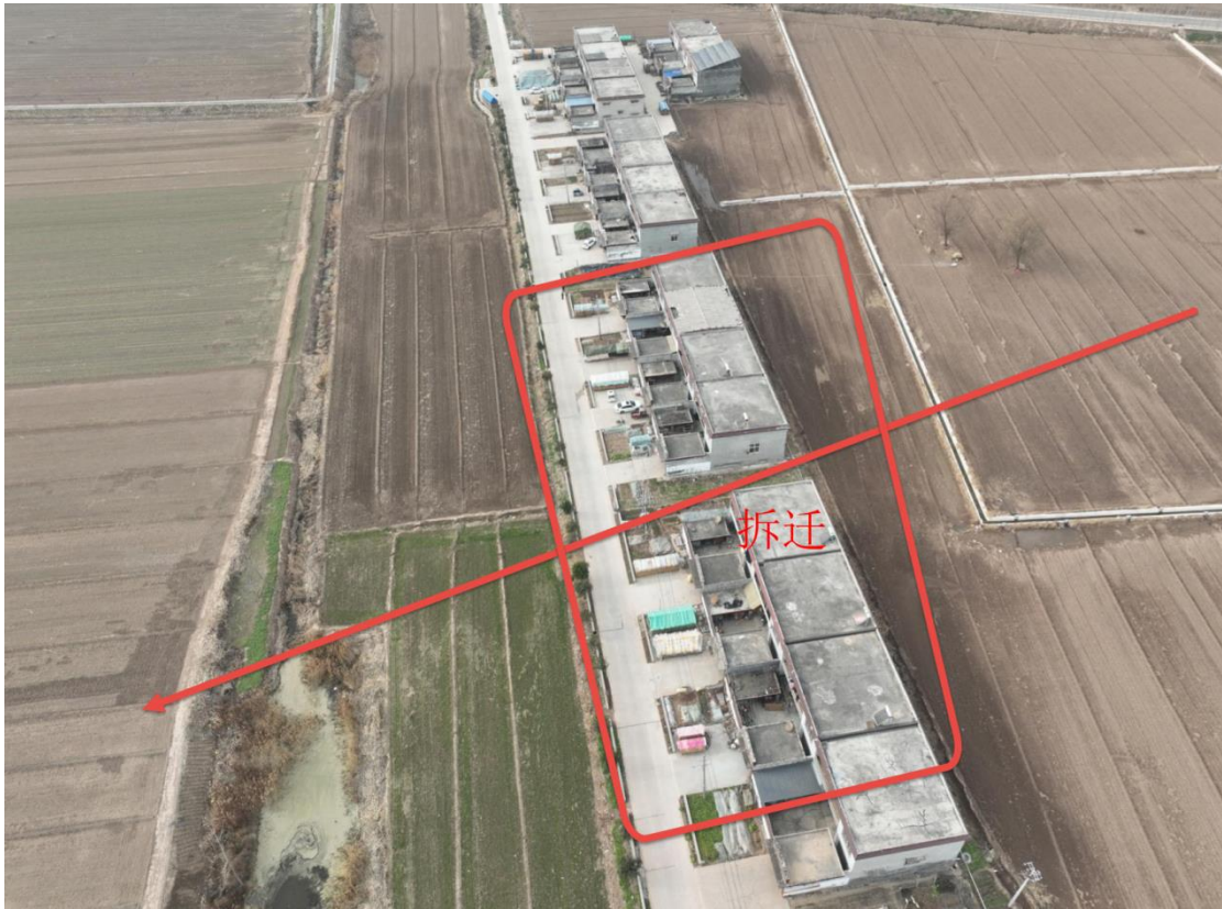
图 2.2.1-4 方案 1 走线及前天平村拆房位置现状
