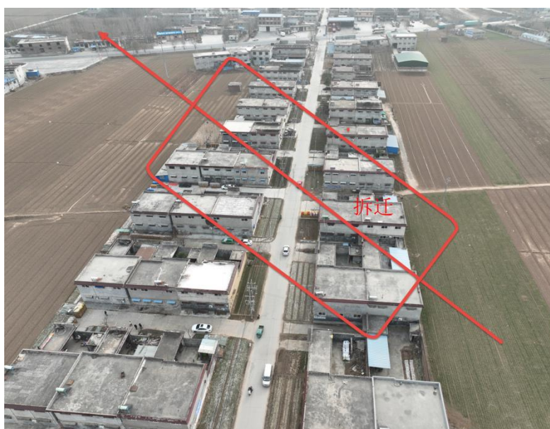
图 2.2.1-9 彦村拆迁房屋位置现状
