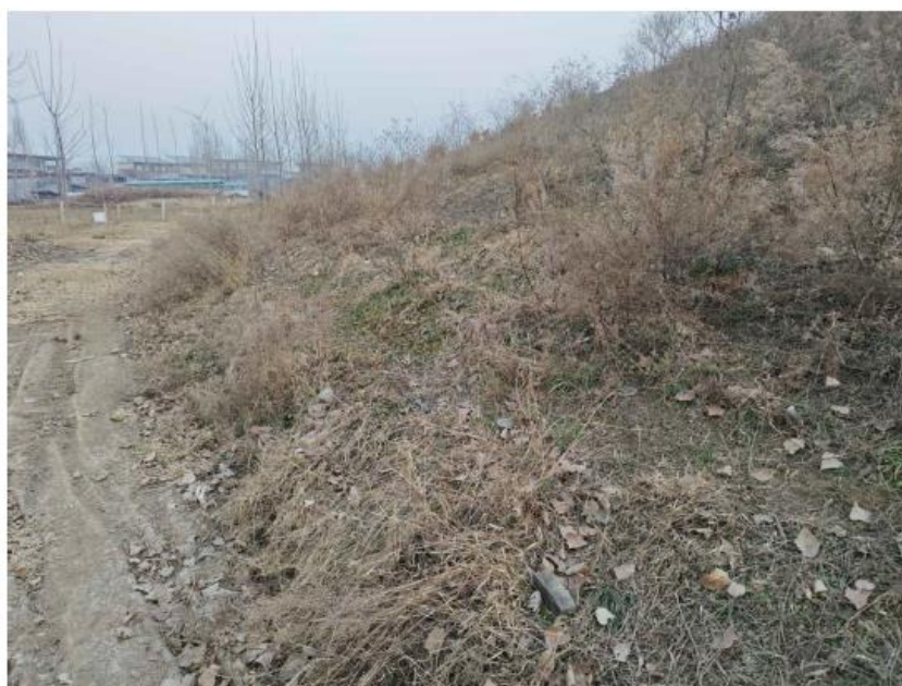
图 8.1-1 上乐村镇西沿村削高坡现状照片
