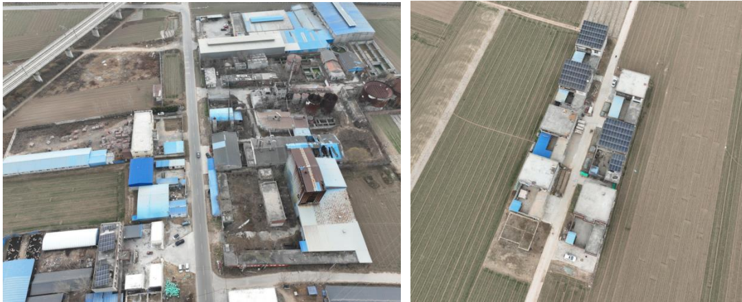
图 2.2.1-13 方案 2 线路在康湾村工厂厂房及民房拆迁
