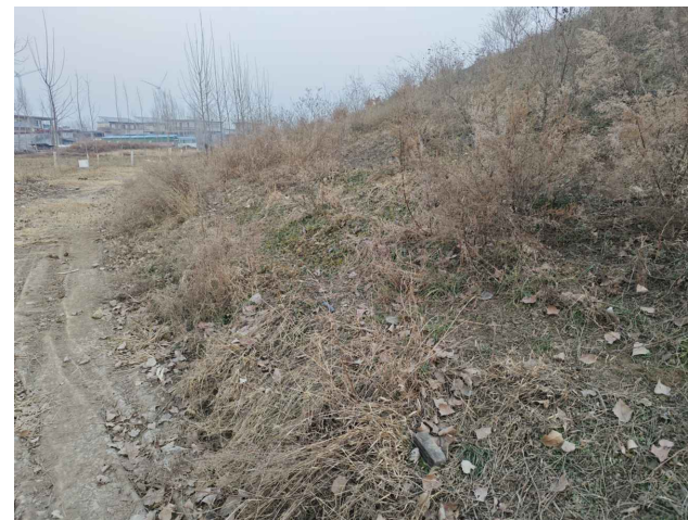
上乐村镇西沿村削土坡现状照片
