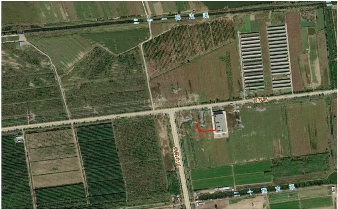
图 2-8 电缆线路周边道路情况
