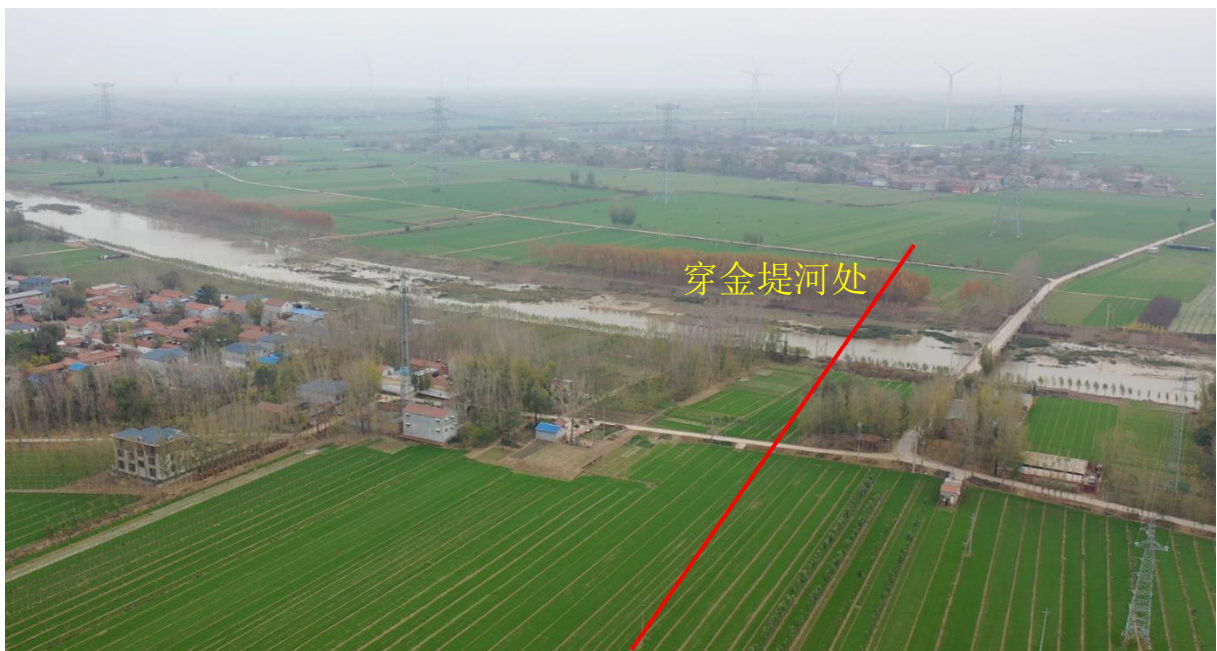
图 2.2-9 管道穿越金堤河处现状
