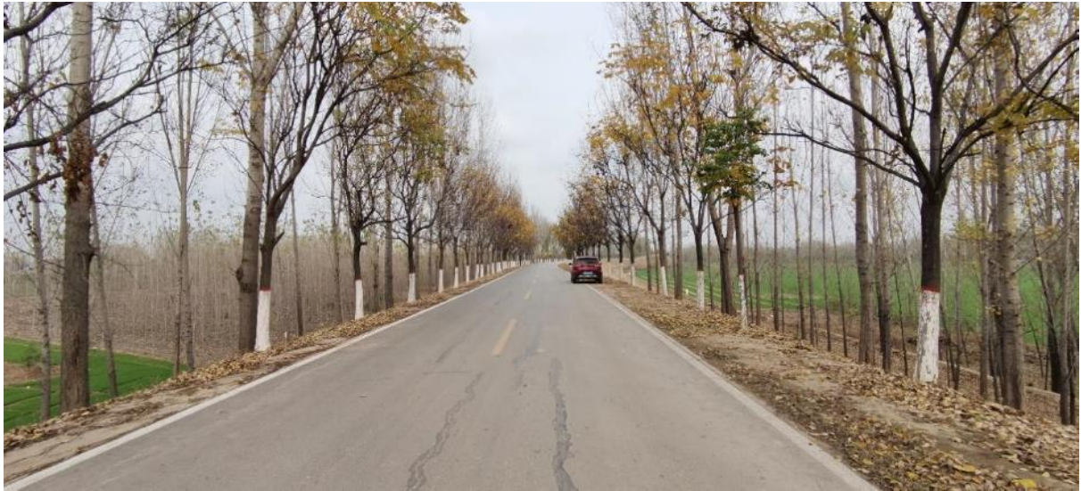
图 2.2-4 管道爬越北金堤处现状图
