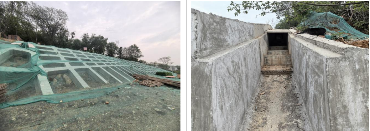
框格骨架护坡、施工裸露面密目网苫盖（2025 年 4 月） 混凝土盖板截水沟（2025 年 4 月）
