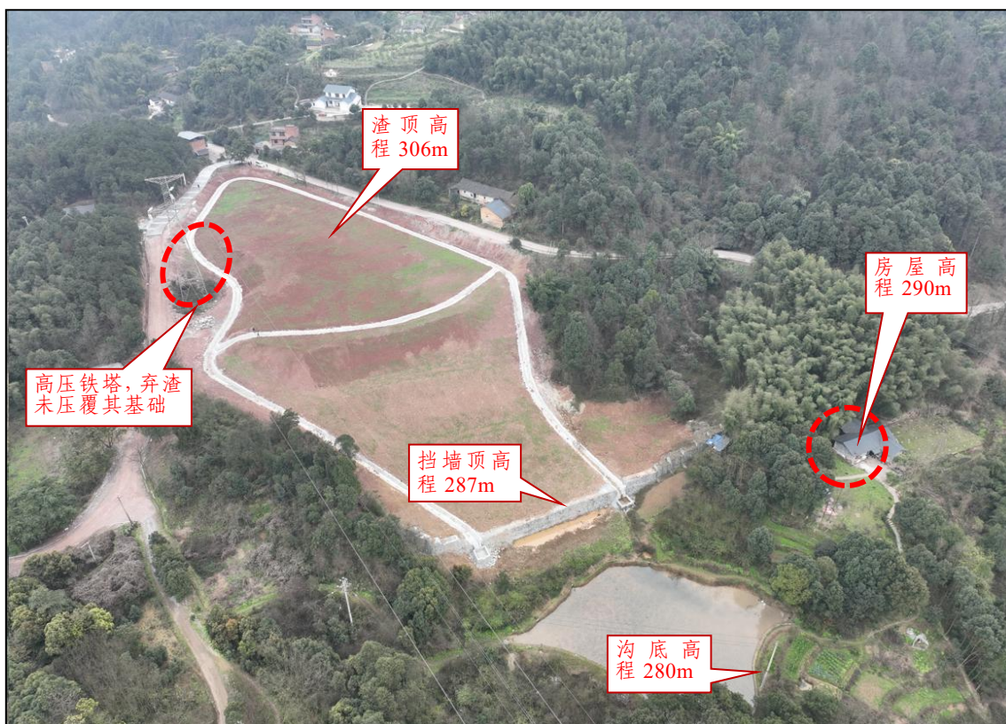
图 3.3-3 1#-缙云山隧道出口弃渣场现状照片
