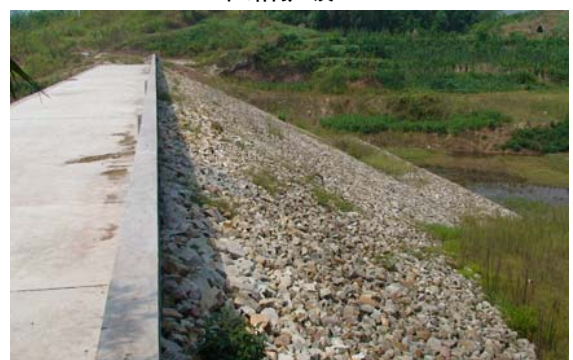
坝体浆砌块石护坡
