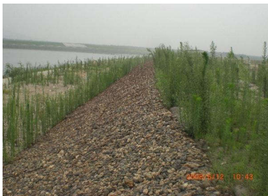
弃渣场雷诺护垫护垫护坡
