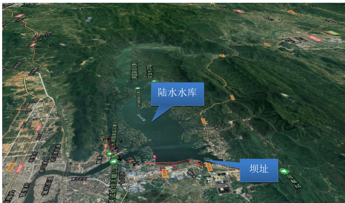
图 2.2-1 陆水水库除险加固工程地形地貌卫星图
