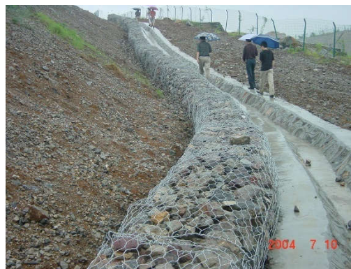
弃渣场石笼网挡墙及浆砌石排水沟
