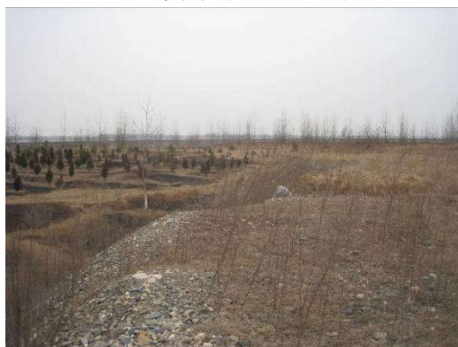
弃渣场植被恢复
