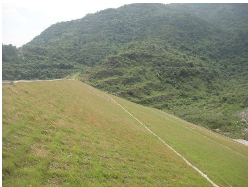
大坝草皮护坡
