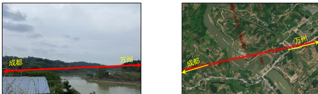
图 2.1-11 亭子镇明月江特大桥现场照片及遥感影像图
