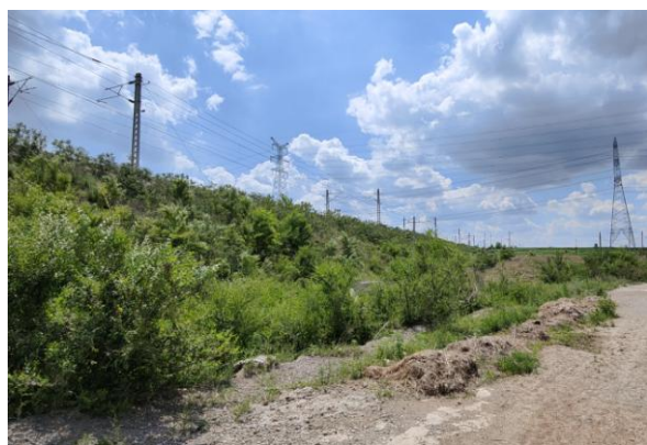
奈曼（金沙）-阜新段跨越铁路
