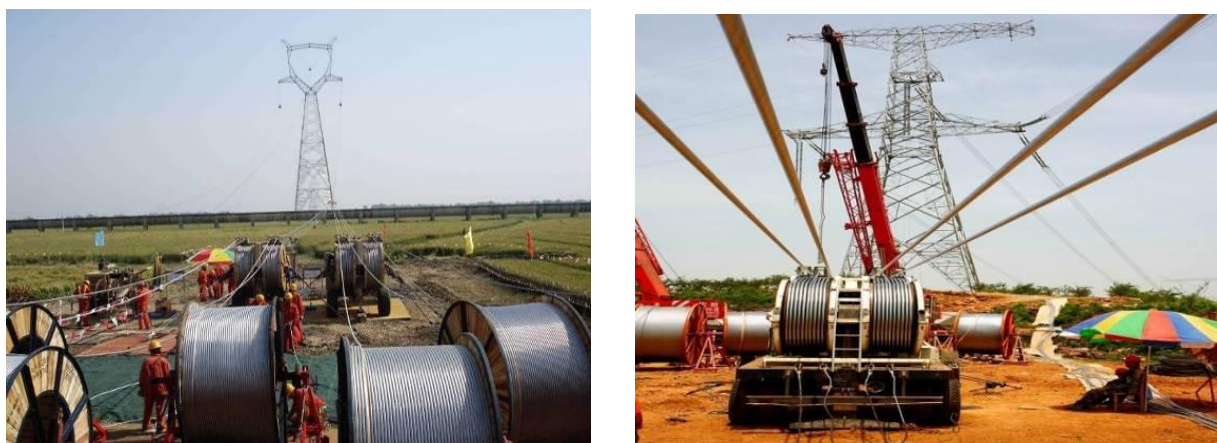
图 2-1 输电线路牵张场地布置实例图
