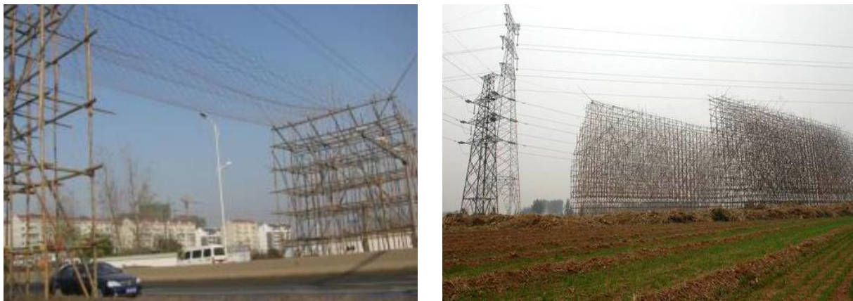
图 2-2 输电线路跨越施工场地布置实例图
