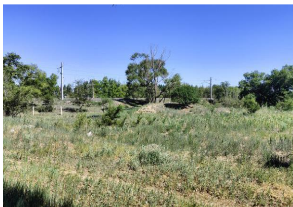
奈曼（金沙）-阜新段跨越巴新铁路
