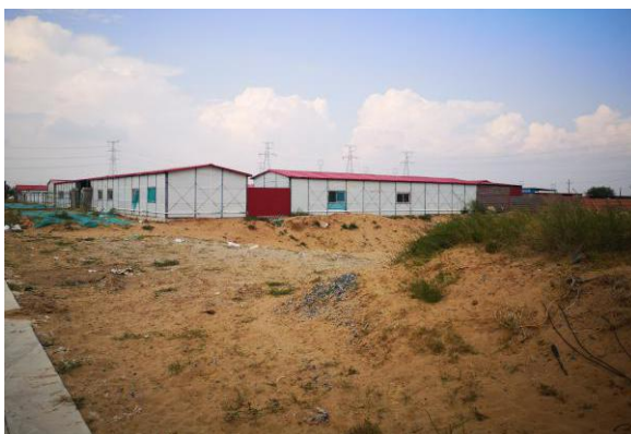
奈曼（金沙）变北侧施工生产生活区
