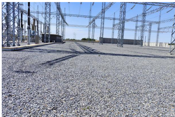
奈曼变站区扩建场地
