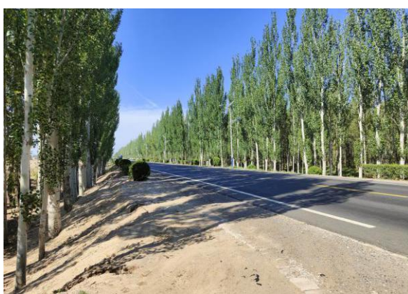
奈曼（金沙）-阜新段跨越 G111 国道（东甸子村南）
