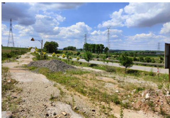
奈曼(金沙)-阜新段跨越朱苍线省道
