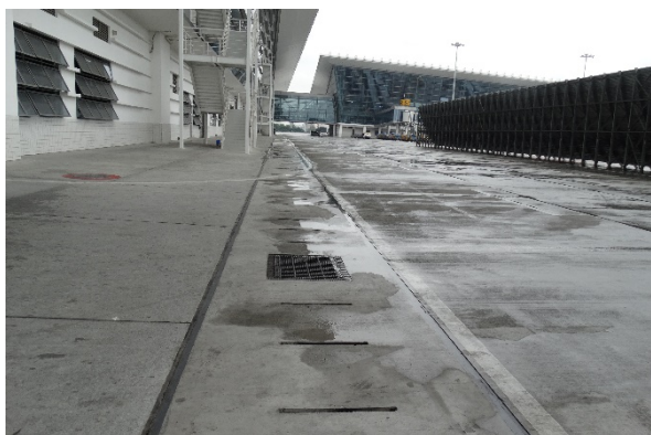
航站区盖板排水沟
