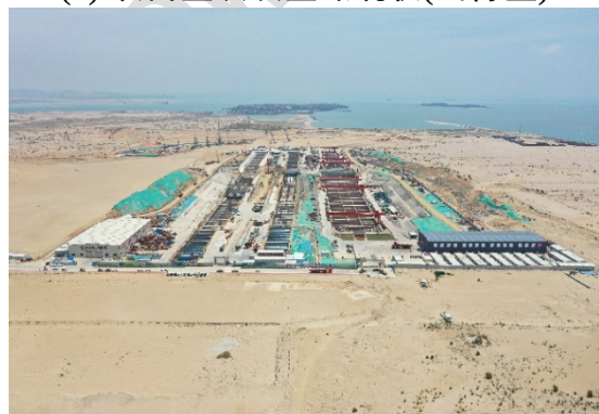
(8) 航站区交通中心(轨道交通 3 号线、4 号线和 R1 线的翔安机场站正在施工)
