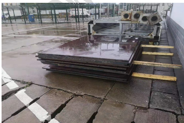
建筑物周边混凝土盖板排水沟
