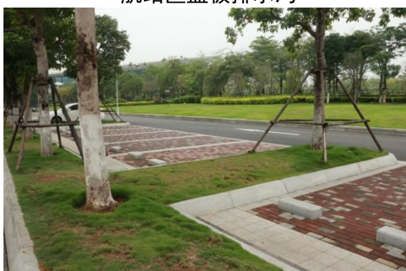
航站区停车场透水砖及绿化
