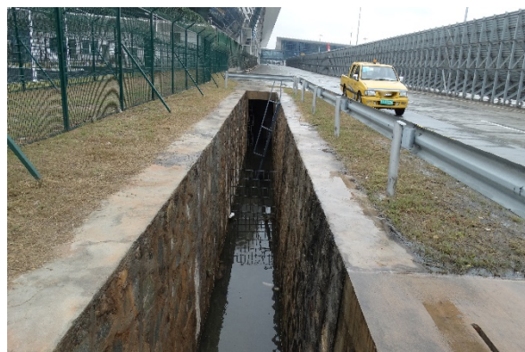
航站区排水明沟
