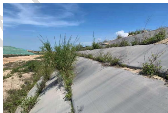
防老化的土工布苫盖(防风固沙)
