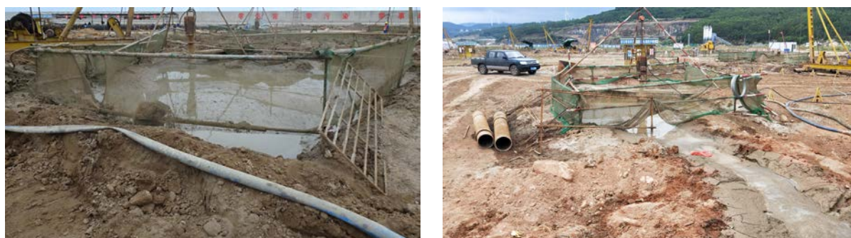
土质泥浆沉淀池
