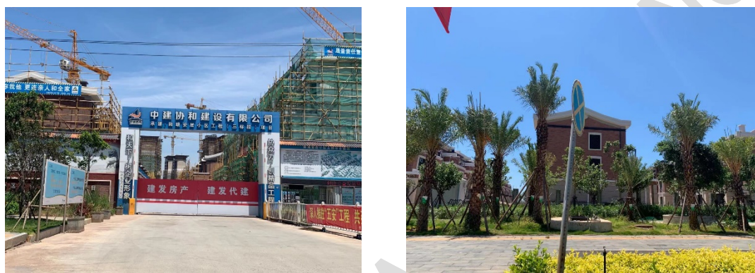
图 2.1-51 阳塘安居小区工程施工现状面貌
