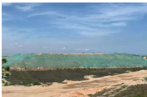
土方中转场临时苫盖
