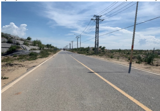
(12) 填海造地已建场内道路
