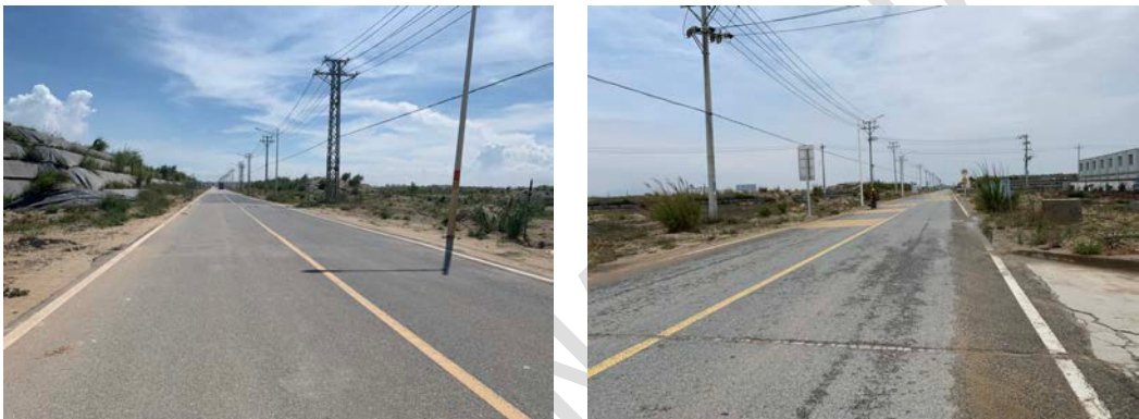
图 2.2-2 机场场址内已建交通道路
