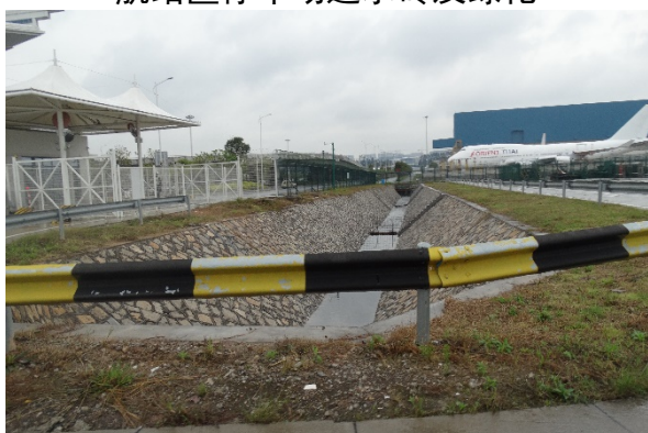
飞行区浆砌石排水明沟
