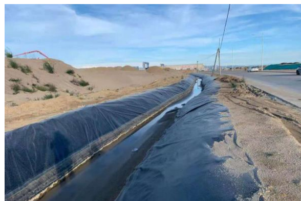
铺高密度聚乙烯土工膜的临时排水沟
