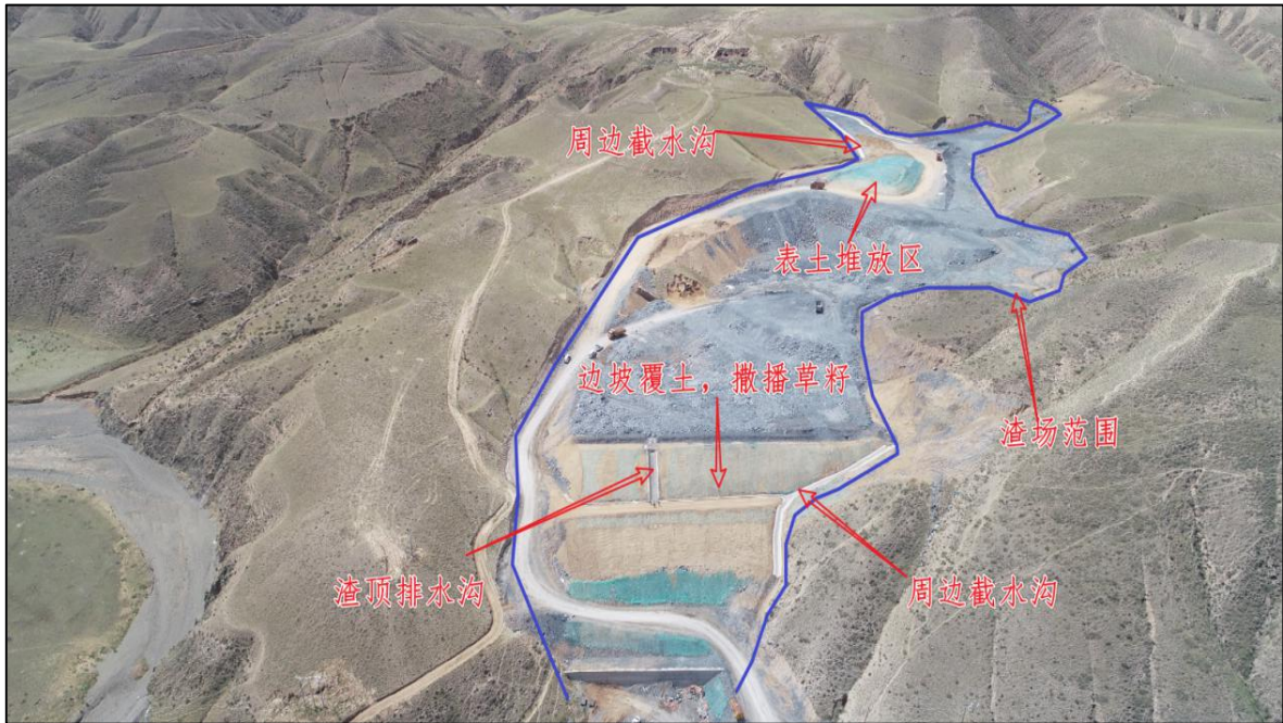
现状航飞图（正在使用中、分级分层堆放）
