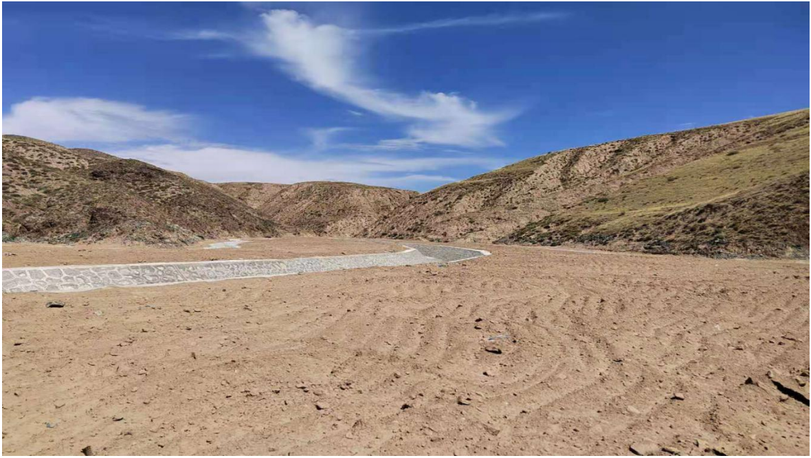
回覆表土、撒播草籽，浆砌片石渣顶排水沟
