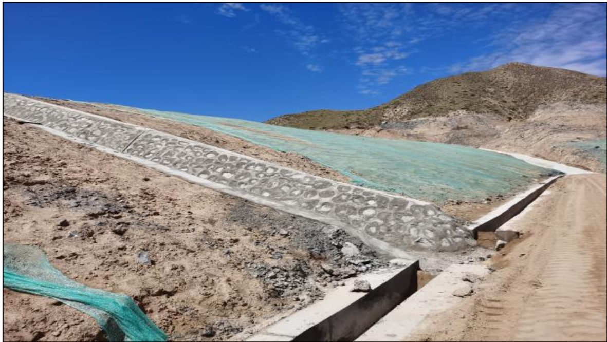
渣顶浆砌石排水沟、平台混凝土排水沟
