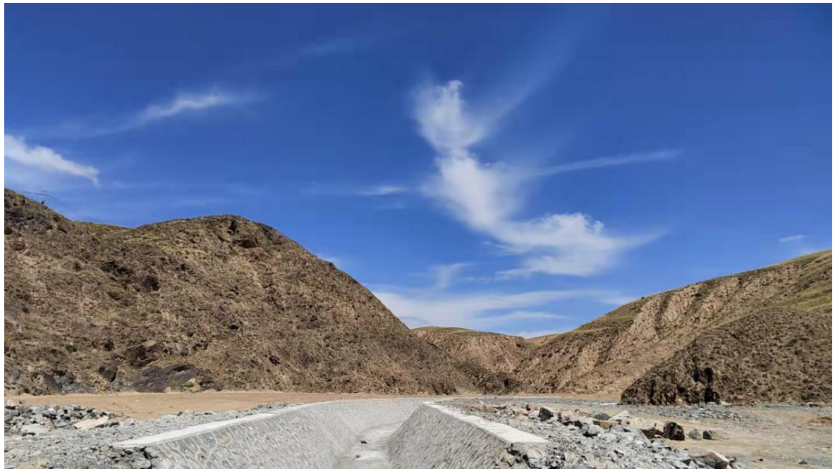
浆砌片石渣顶排水沟
