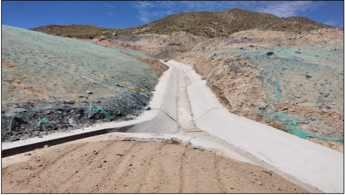
周边混凝土截水沟
