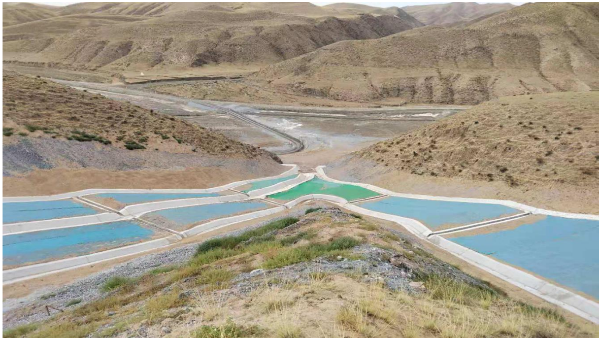
边坡覆土、绿化，周边混凝土截水沟，混凝土渣顶排水沟、平台混凝土排水沟
