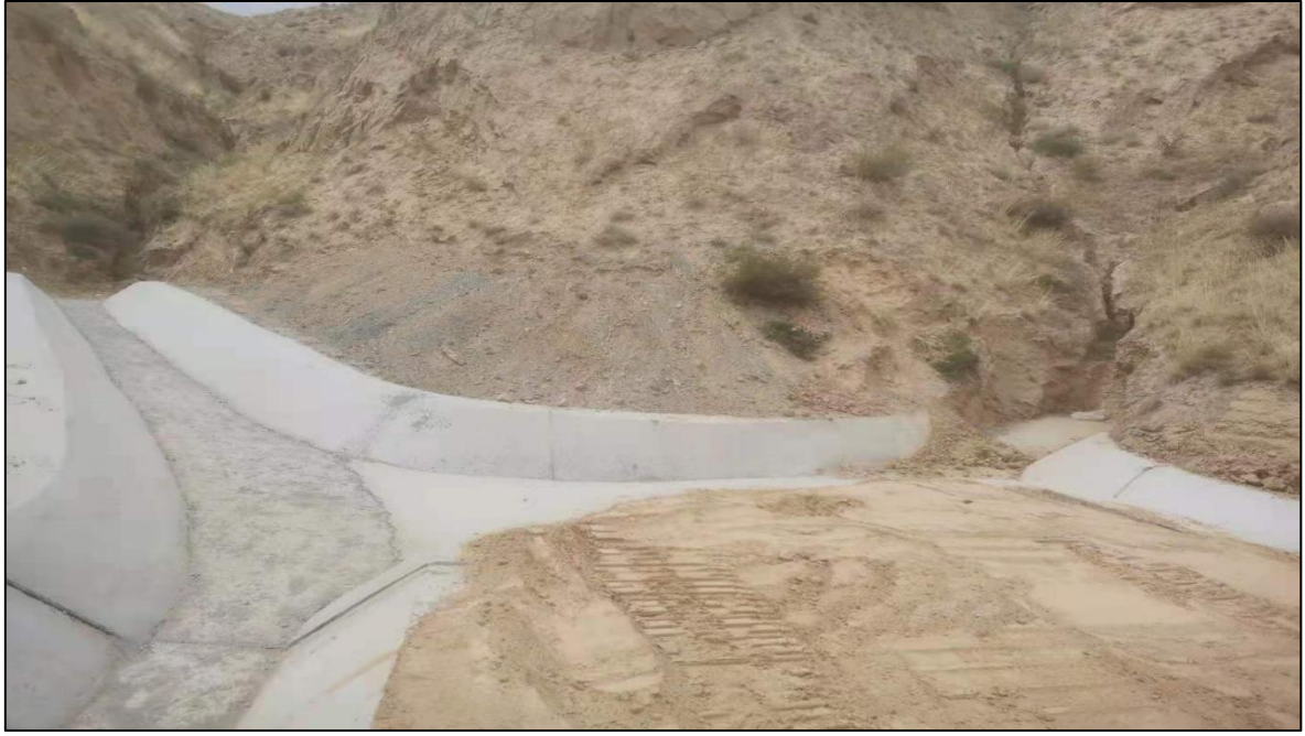
周边混凝土截水沟
