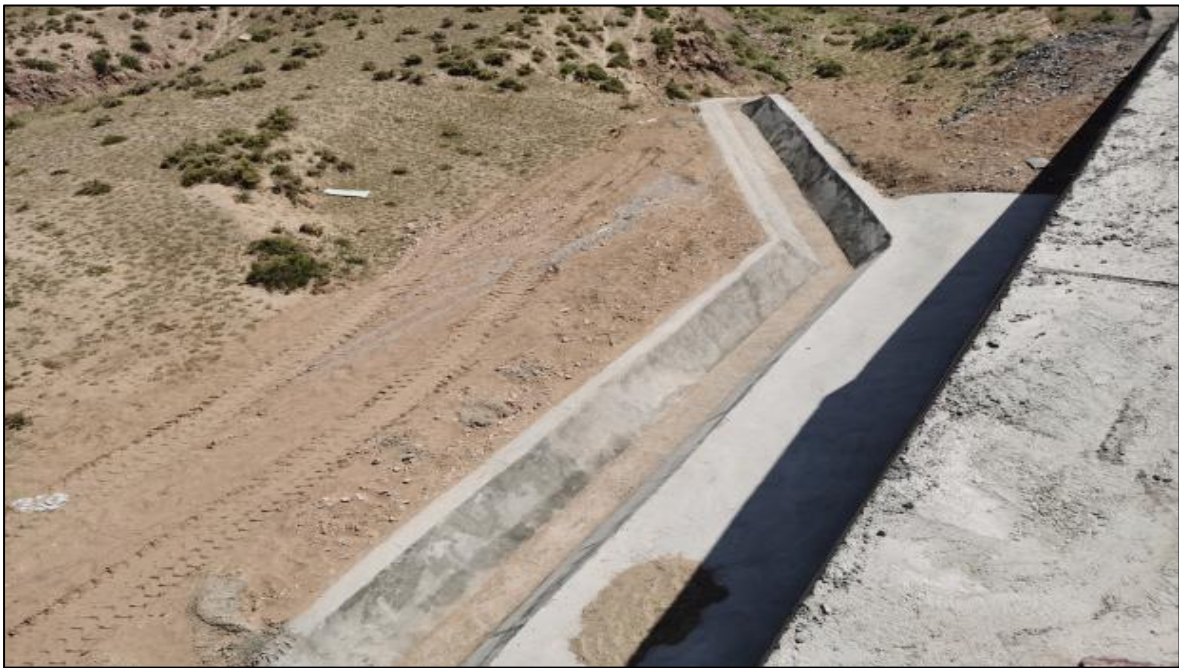
周边混凝土截水沟
