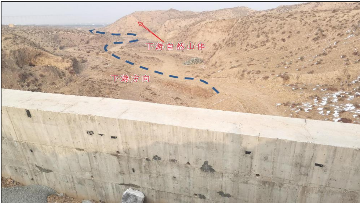
渣场挡墙下游方向
