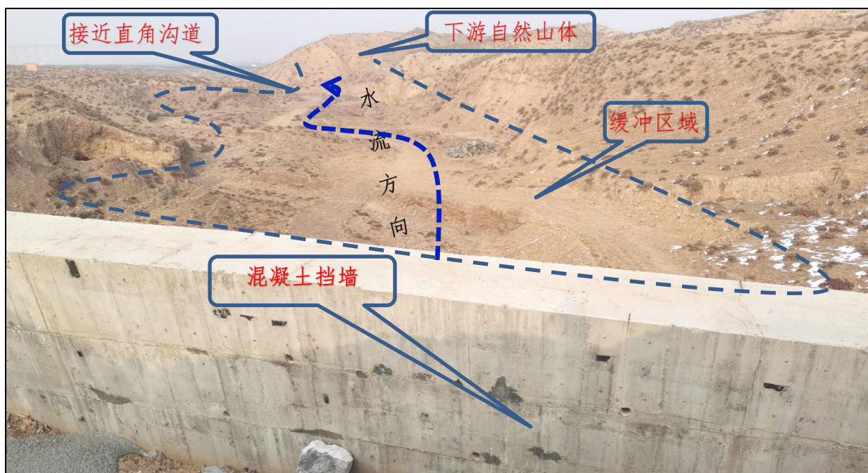
图 3.2-7 拟变更香山隧道进口弃渣场下游水流向
