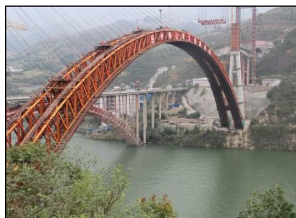
跨河桥墩处临时防护
