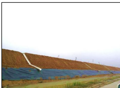
路基临时排水及苫盖
