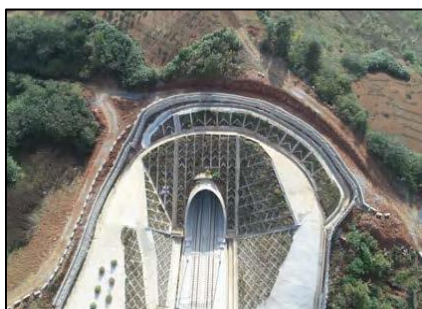
隧道洞口边坡防护
