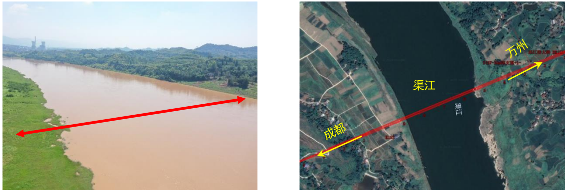
图 2.1-27 渠江特大桥现场照片及遥感影像图
