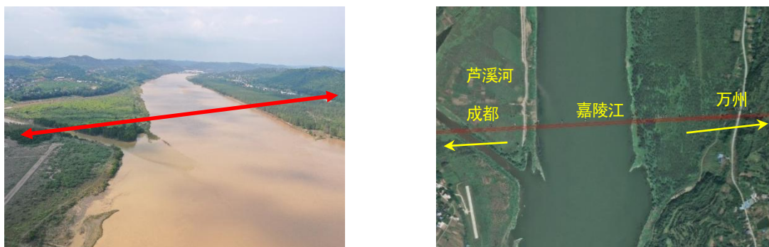
图 2.1-29 南充嘉陵江特大桥现场照片及遥感影像图
