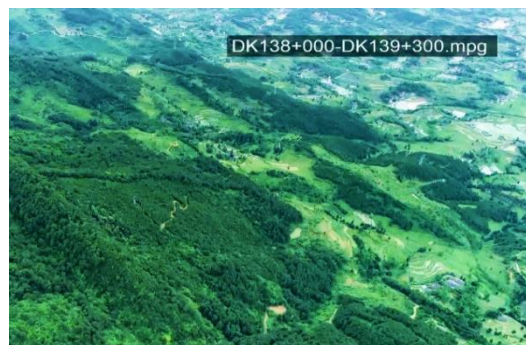
华蓥山隧道出口
