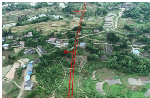
铜锣山隧道进口
