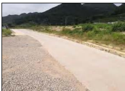
施工便道碎石硬化
