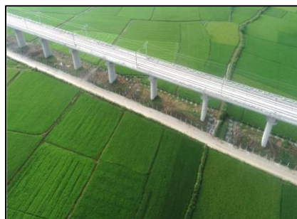
施工便道复垦
