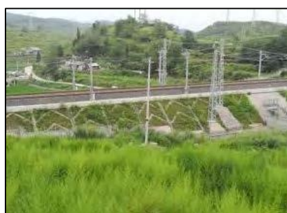
路堤边坡防护
