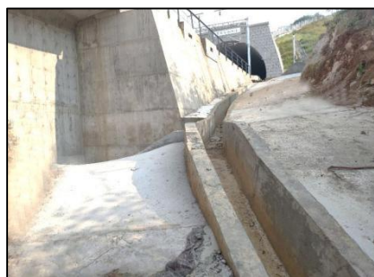
隧道洞口排水顺接工程
