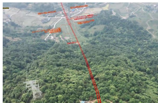
铜锣山隧道出口
