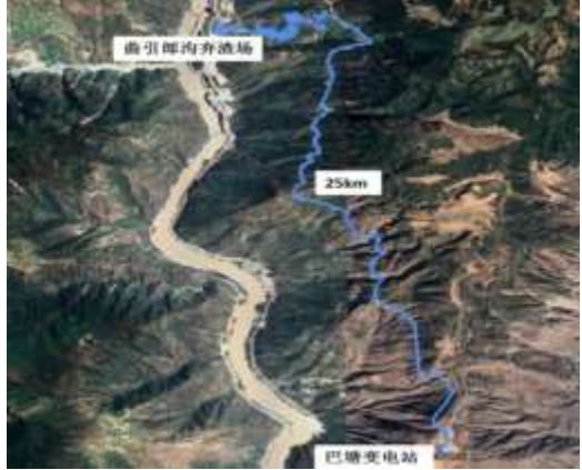
曲引朗沟弃渣场距离巴塘变电站位置
