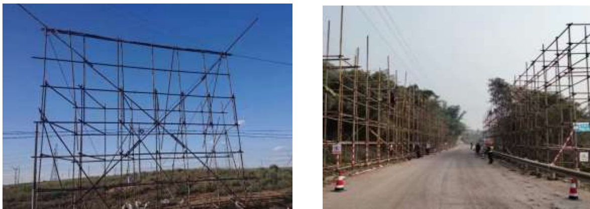
图 2.2-2 线路工程临时跨越占地
