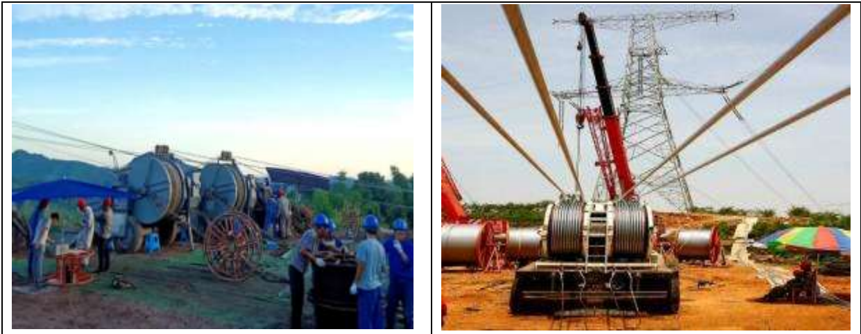
图 2.2-1 输电线路牵张场布置型式
