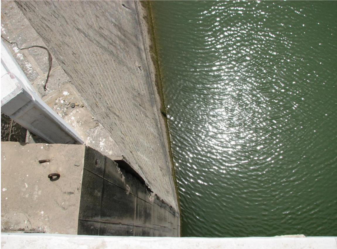
图 2.1-4 下游翼墙局部图（翼墙顶部错位明显）
