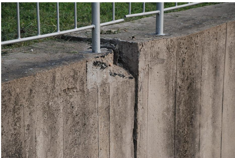
图 2.1-3 上游翼墙局部图（顶部开裂、下沉）
