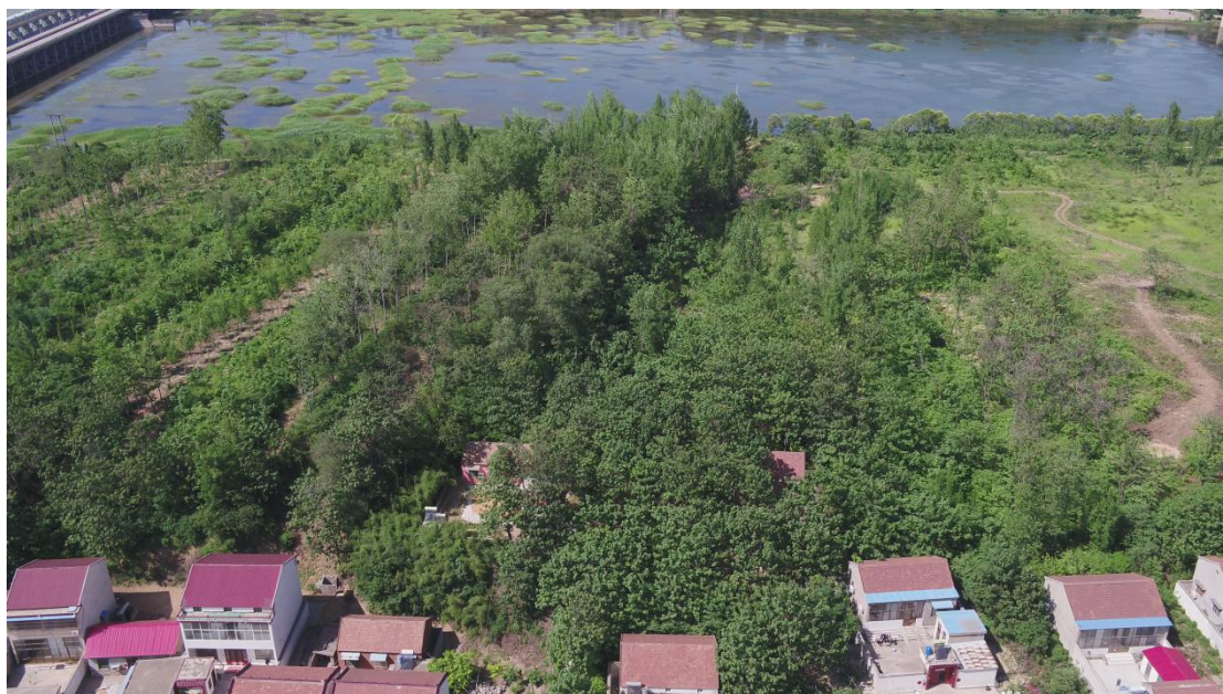
图 2.1-3 取（弃）土区现状图片
