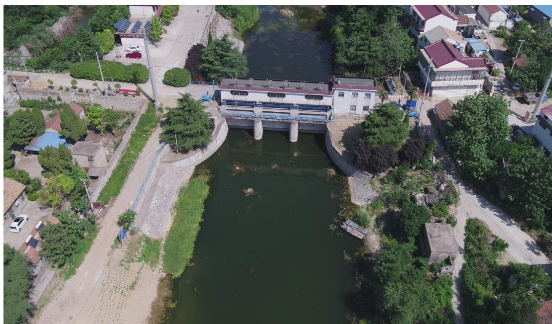
图 2.1-2 伊家河闸现状图片
