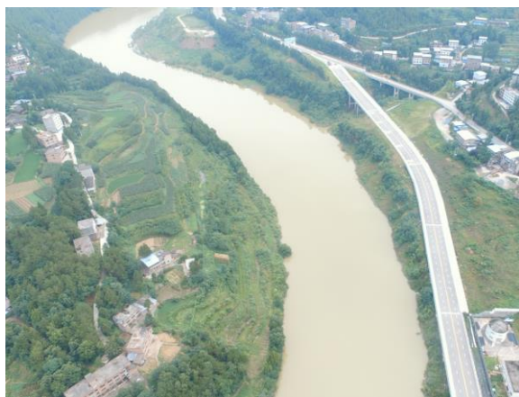
坝址下游施工场地
