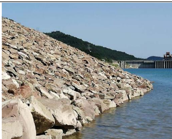
库区型弃渣场砌石护坡
