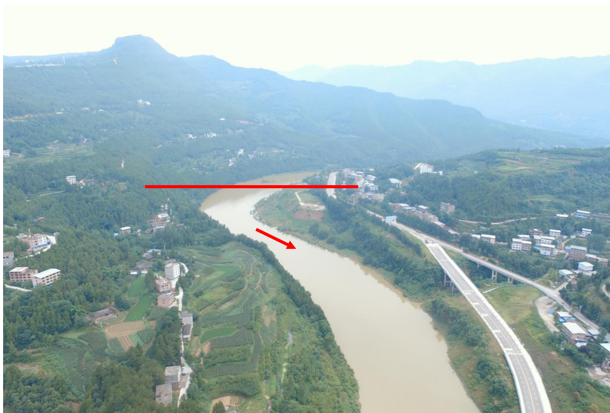
图 2.2-1 坝址施工区地形地貌航拍图
