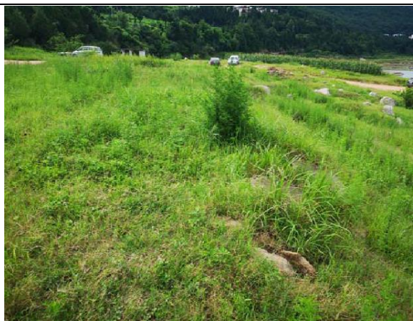
弃渣场植被恢复
