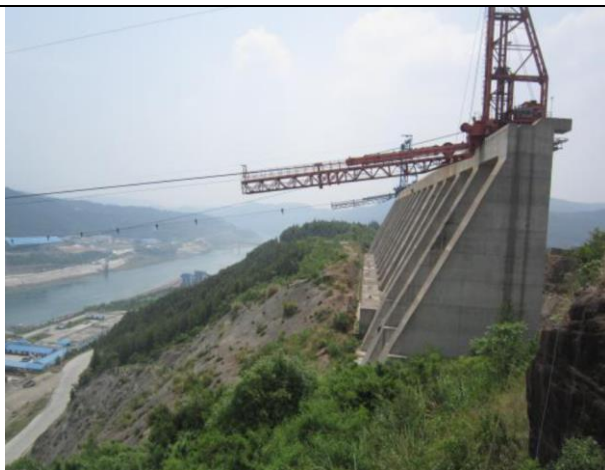
大坝边坡防护措施
