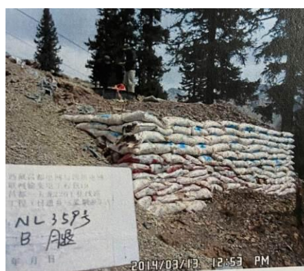
图 5-10 坡面土袋挡墙挡护示例
