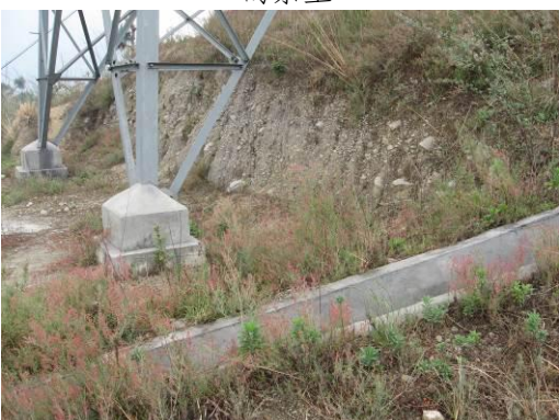
图 5-8 坡地典型示例 4：修建排水沟
