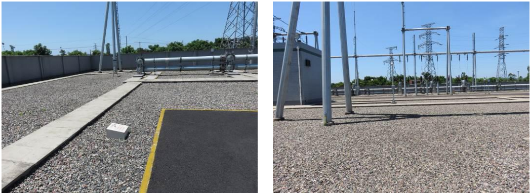
图 5-2 变电站配电装置区碎石地坪示例
