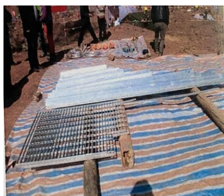
图 5-11 塔基施工临时占地铺垫隔离示例
