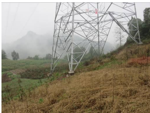
图 5-5 坡地典型示例 1：余土根据地势填至低洼坑凹处
