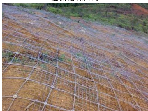
图 5-7 坡地典型示例 3：高陡边坡设主动防护网
