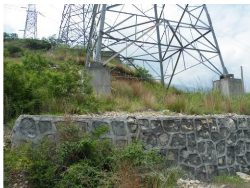
图 5-6 坡地典型示例 2：结合挡墙堆放的余土
