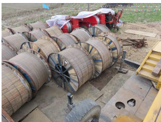
图 5-13 牵张场彩条布苫盖、铺垫钢板
