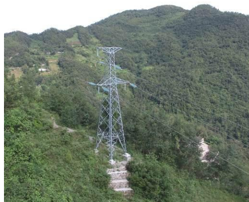
图 5-4 平缓塔位典型示例 2: 结合挡墙处置余土
