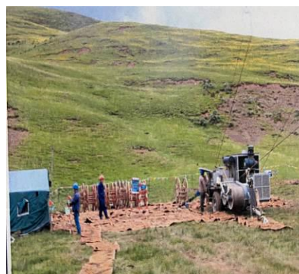
图 5-14 在牵张机具下铺设草垫示例
