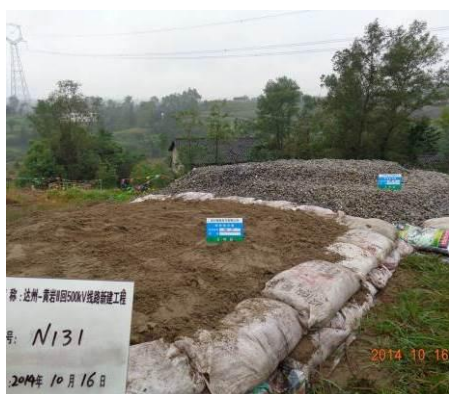
图 5-9 平地临时堆土土袋挡护示例
