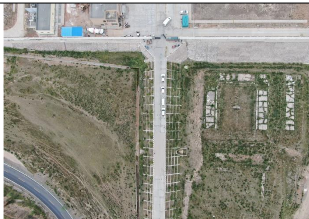
站外排水沟及进站道路骨架植草护坡
