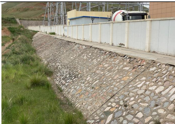
武胜变电站围墙外浆砌石护坡
