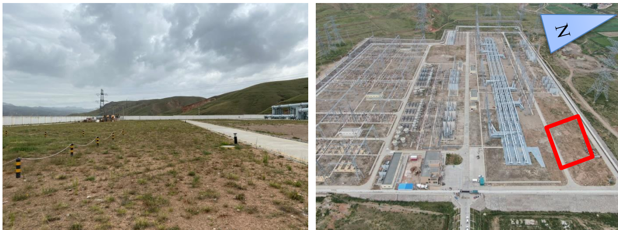
武胜变电站本期扩建场地现状
