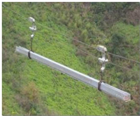
同类工程索道运输照片
