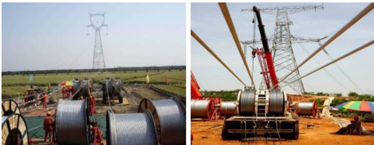
同类工程牵张场布置方式照片
