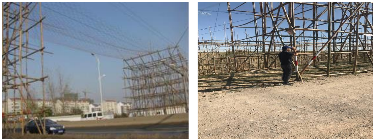
同类工程跨越施工场地布置方式
