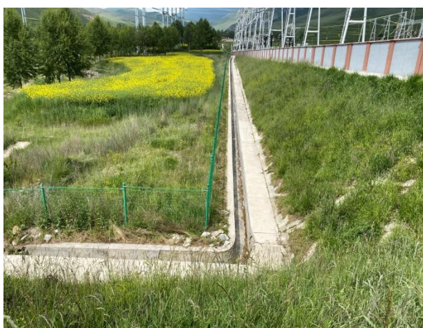
郭隆变电站站外护坡及排水沟
