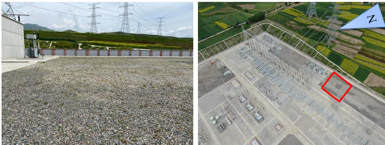
郭隆变电站本期扩建场地现状
