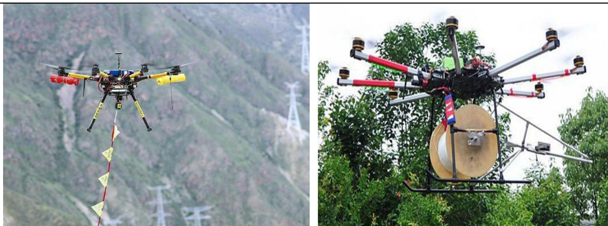
同类工程无人机展放导引绳施工照片
