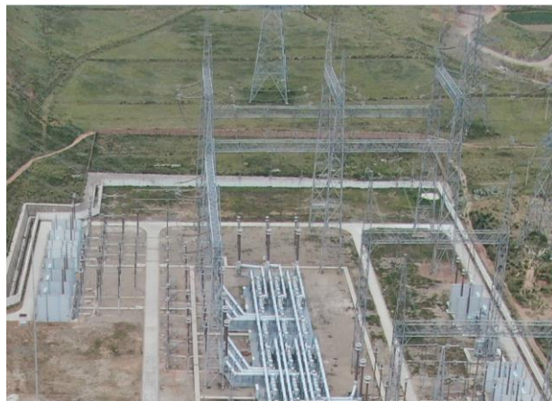
武胜变电站地貌现状
