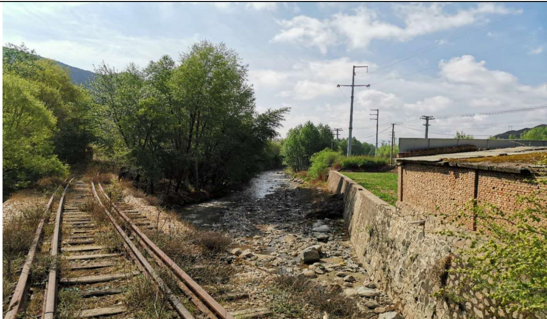
线路跨越引胜沟处现状
