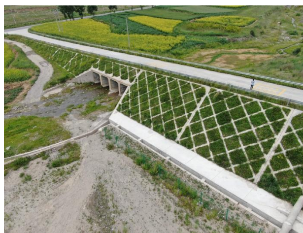
郭隆变电站进站道路护坡及排水沟
