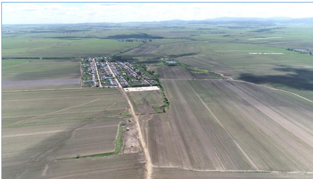
图 2.7-1 (b) 施工生产生活区施工道路地貌现状
