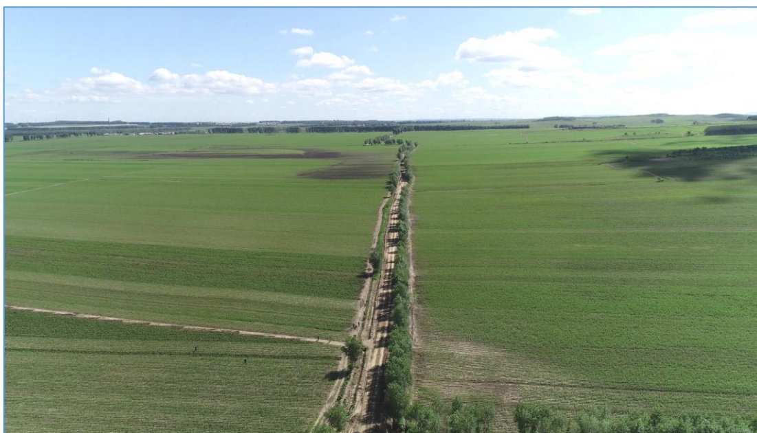
图 2.7-1 (c) 管线工程地貌现状
