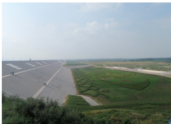
图 2.2-4 坝后区域植被建设
