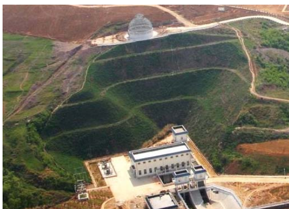
图 2.2-3 输水洞出口边坡植被砼喷护
