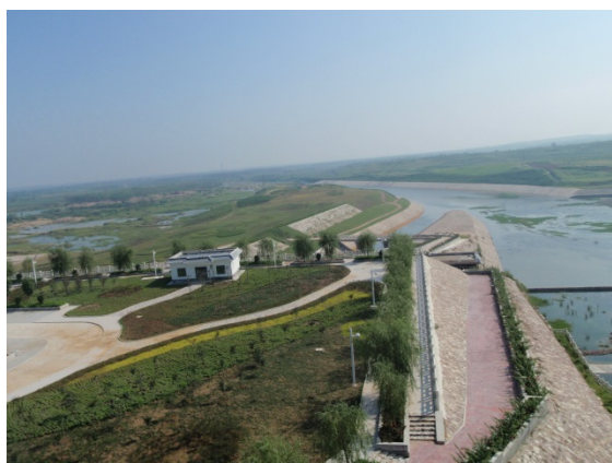
图 2.2-6 溢洪道左岸植被建设
