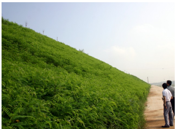
图 2.2-7 溢洪道尾水渠三维网植草护坡
