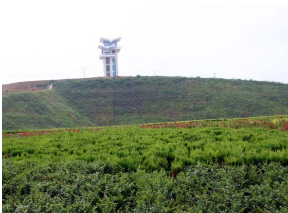
图 2.2-8 溢洪道右岸陡坡生态袋绿化
