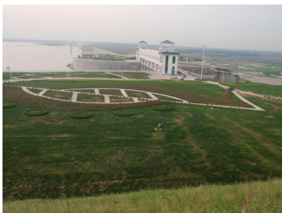
图 2.2-5 大坝右岸植被建设
