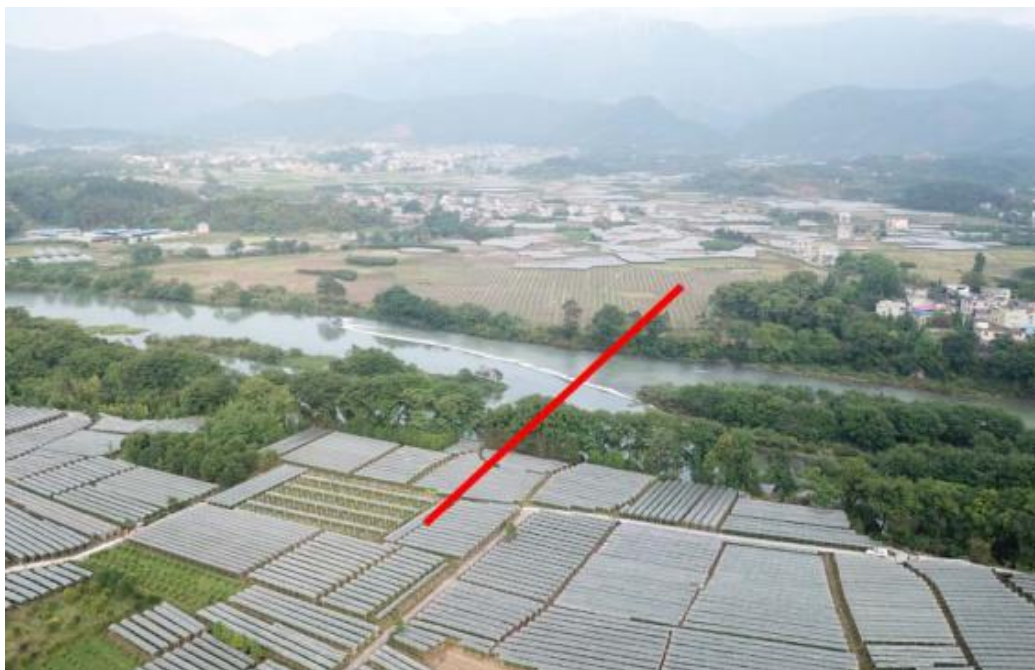
图 2.1-32 溶江镇漓江跨越处地形地貌现状
