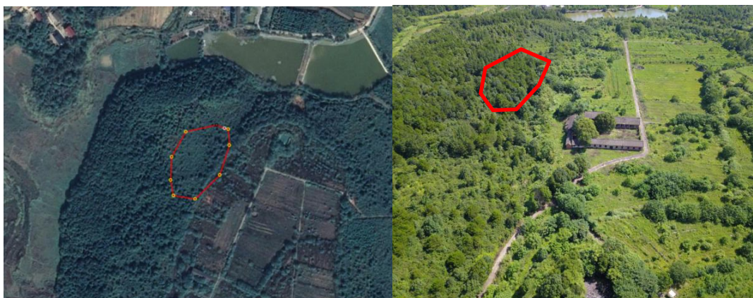
图 2.2-4 潇水西岸弃渣场
