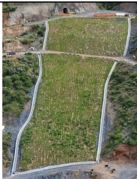
日阿额隧洞支洞渣场现状
