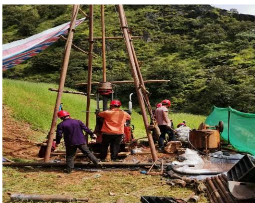
图 4-3 日阿额隧洞渣场钻孔
