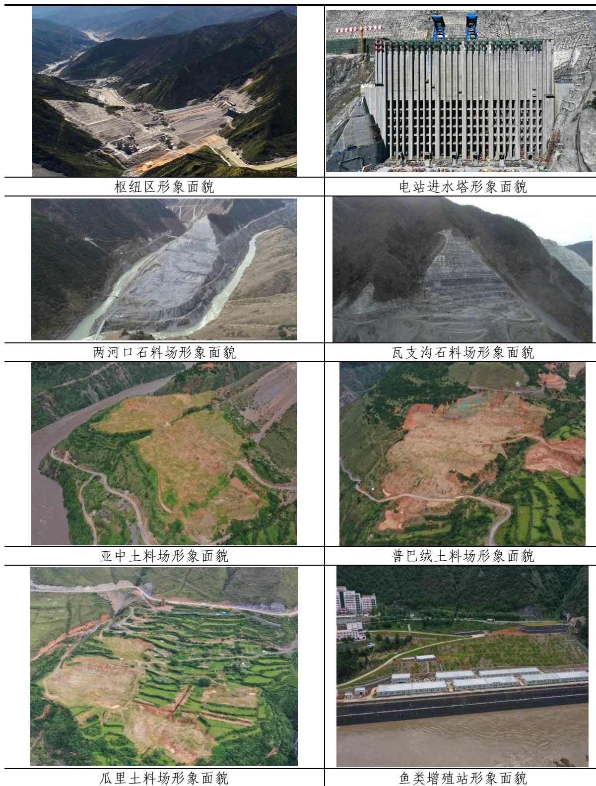
图1-1 两河口水电站各施工区2020年9月形象面貌
