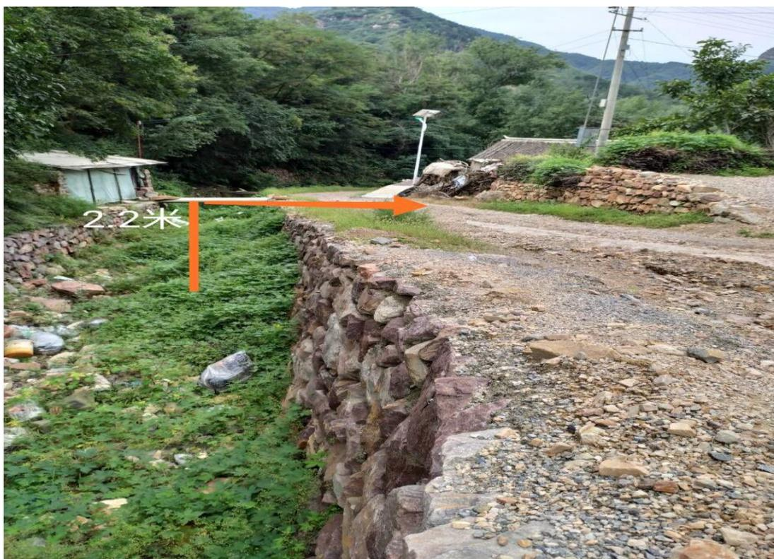
该渣场下游 82m 为居民点，挡墙处高程 529m，居民点处高程 523m，下游平均坡度 7.3%，居民点位于沟岸上，与沟底高差 2.2m。
