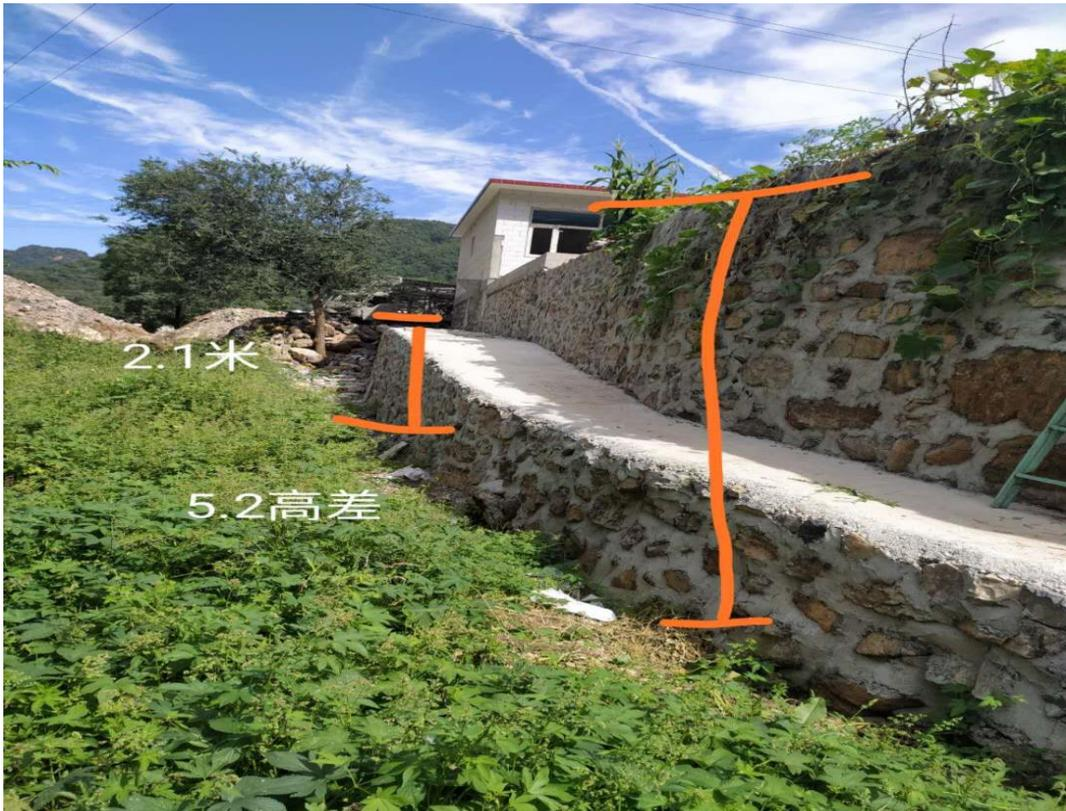
渣场下游 633m 为居民点、815m 为京沈桥梁，渣场不直冲居民点和桥梁，挡墙处高程 630m，居民点处高程 563m，桥梁处高程 553m，居民点位于沟岸上，与沟底高差 2.1m。
