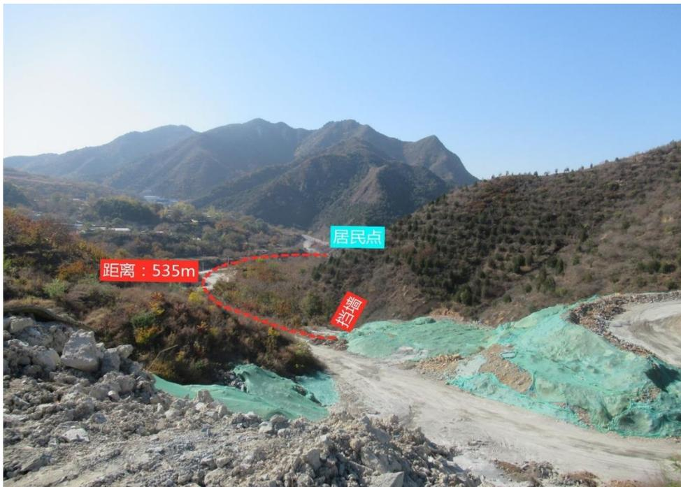
渣场下游 535m 为居民点，渣场不直冲居民点，挡墙处高程 399m，居民点处高程 367m，坡度 6.0%。
