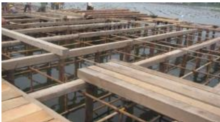
图2.2-1 水上施工作业平台图
