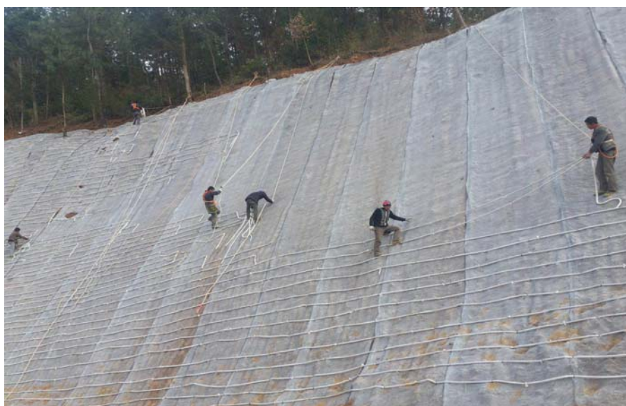
图 10.3-2 植生毯施工现场
