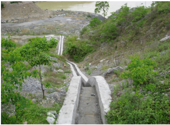
弃渣场排水沟
