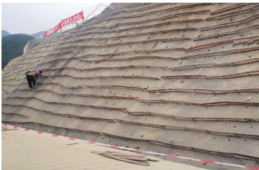
图 10.3-1 挂镀锌铁丝网厚基质喷播植草施工现场
