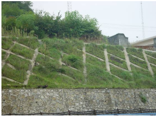
道路边坡防护
