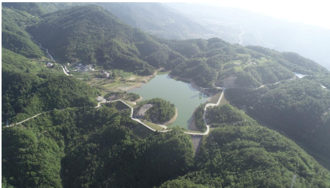
图 4.2-8 田家坪水库现状
