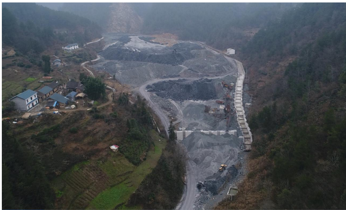
图 4.2-7 弃渣场现状照片
