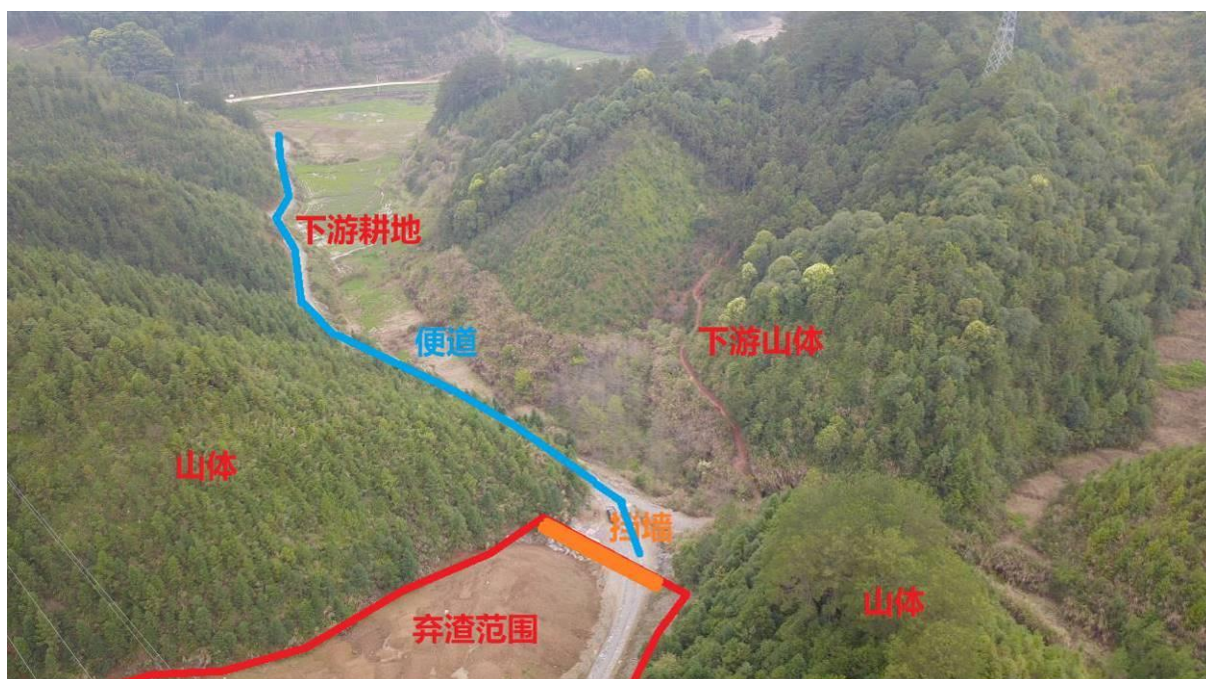
图 2.2.4.1-53 弃渣场下游现状图
