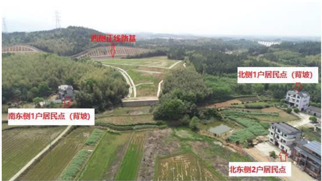
图 2.2.4.1-13 弃土场航拍现状图
