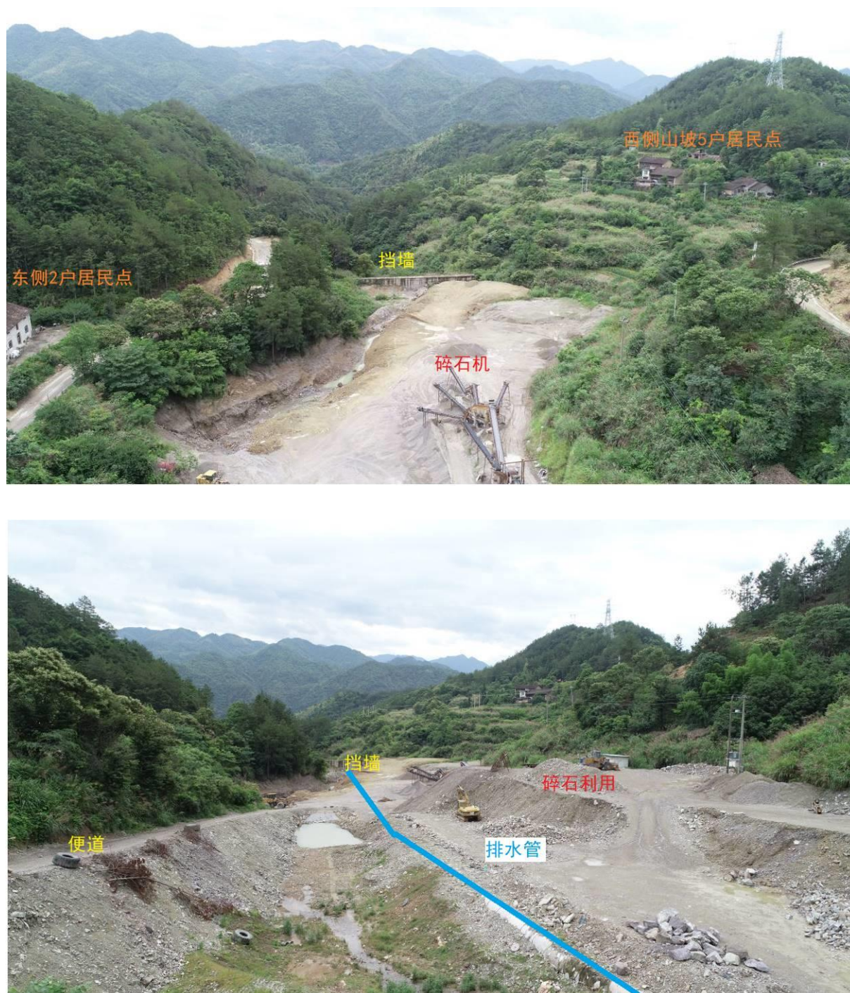
图 2.2.4.2-5 弃渣场现状图
