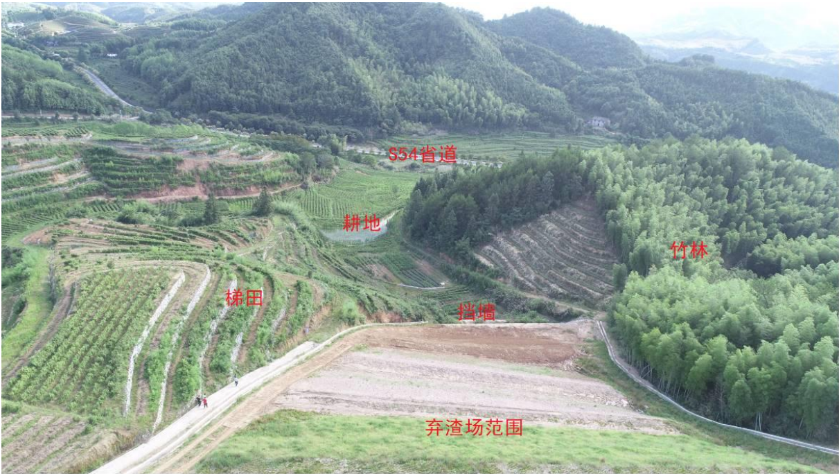
图 2.2.4.1-25 弃渣场下游现状图
