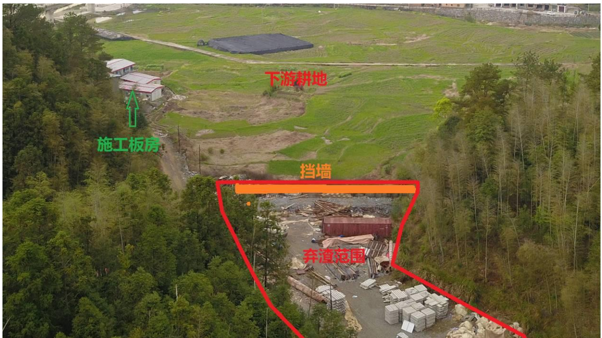
图 2.2.4.1-60 弃渣场下游现状图
