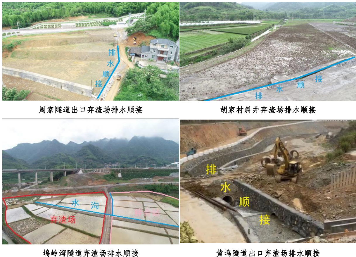
图 4.4.1-3 已实施的排水顺接工程现状图
