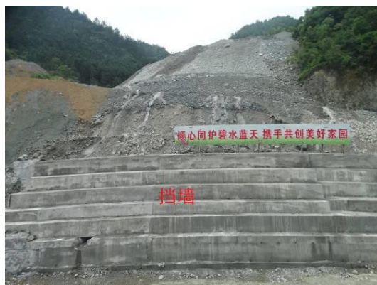
大路下斜井弃渣场挡墙
