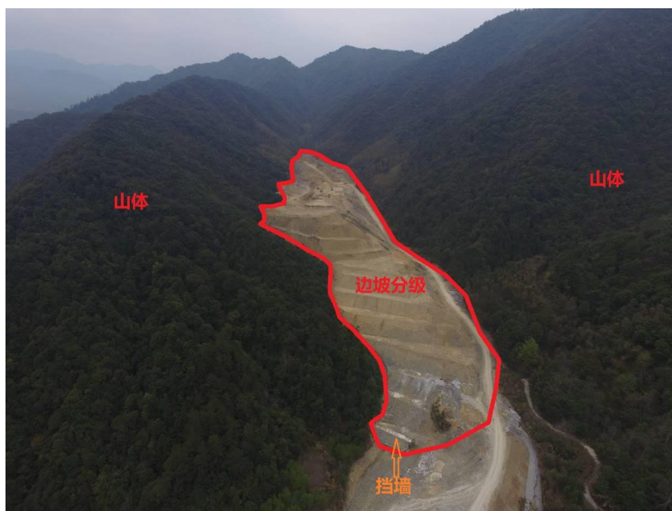
图 2.2.4.1-63 弃土场航拍现状图
