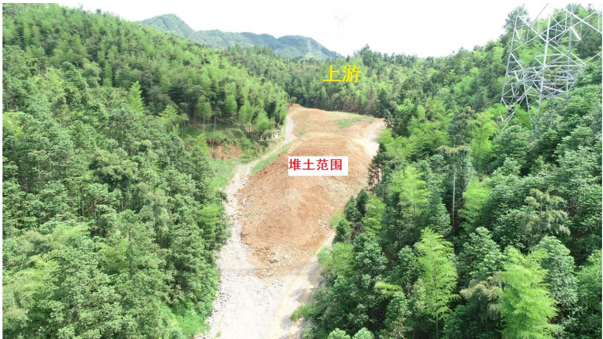
图 2.2.4.1-59 弃渣场航拍现状图（上游拍摄）
