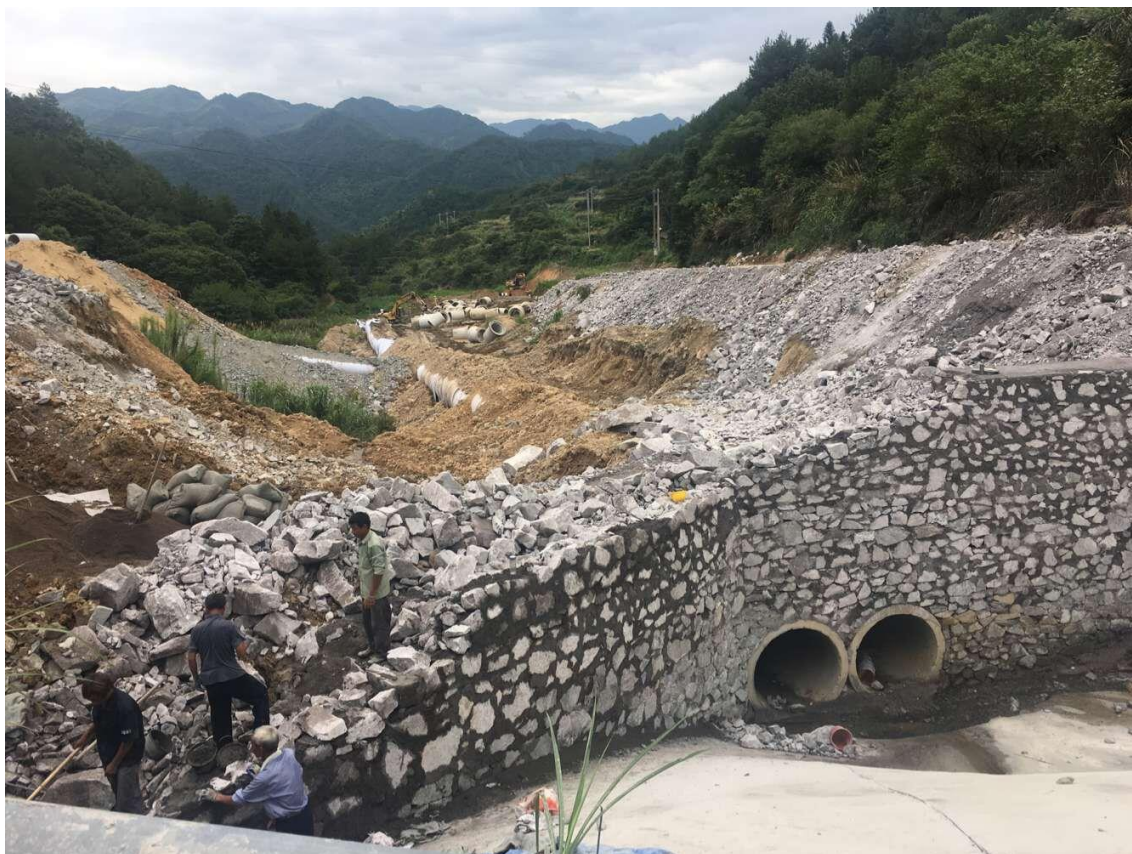
图 4.3.1-3 杨梅岭隧道出口弃渣场弃渣前布设排水管和实施挡墙
