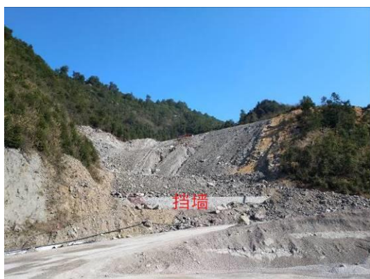
樟坪斜井弃渣场挡墙
