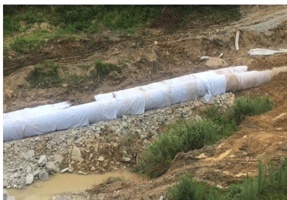
杨梅岭进口施工排水涵管
