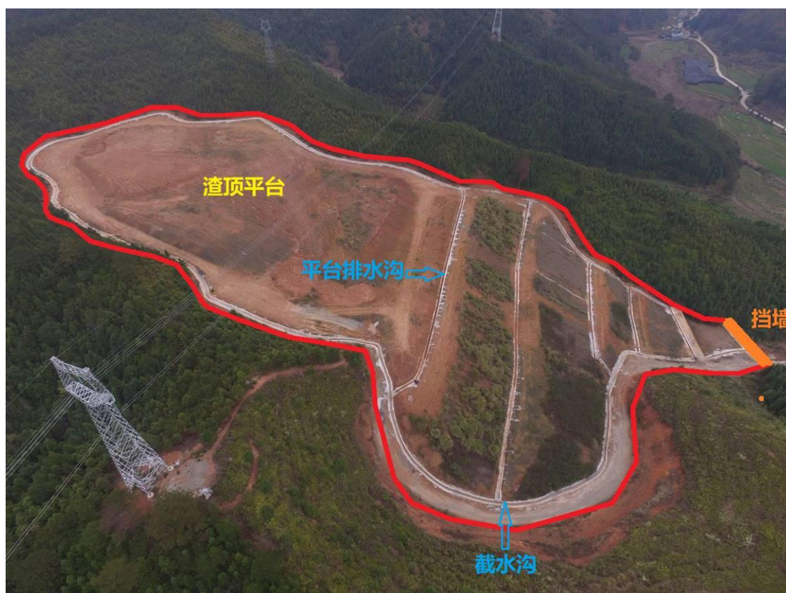
图 2.2.4.1-48 弃土场航拍现状图
