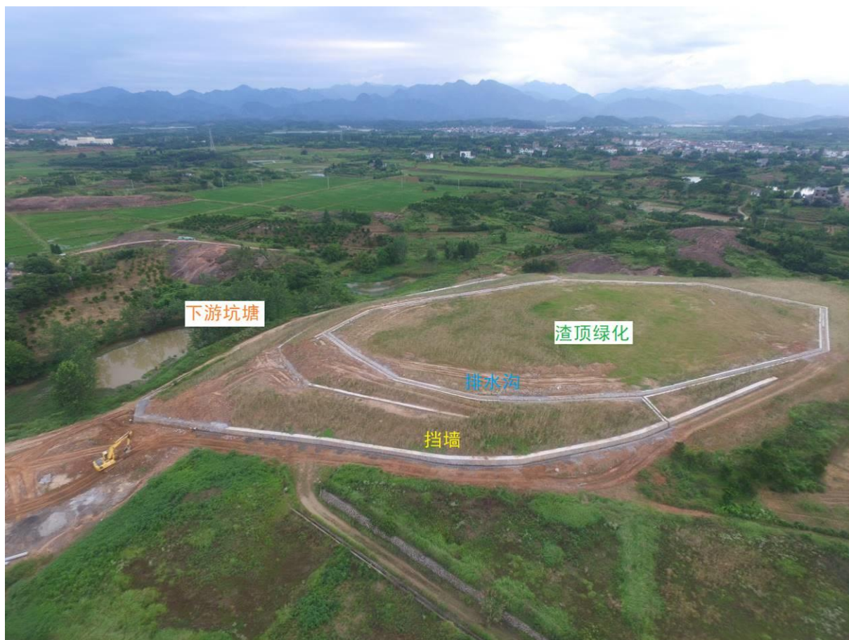
图 2.2.4.1-9 弃土场航拍现状图及措施实施情况图
