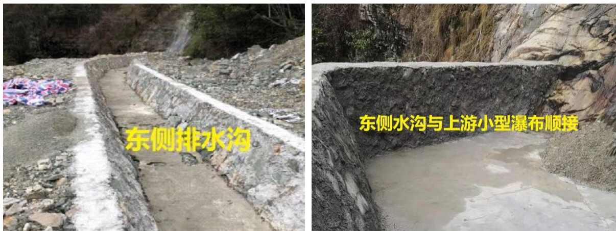
图 2.2.4.1-41 施工过程中的临时排水沟措施现状图
