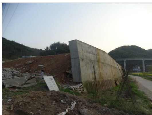
下庄隧道进口弃渣场挡墙
