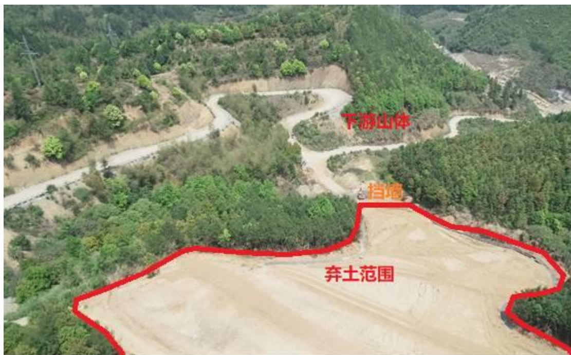
图 2.2.4.1-31 弃渣场下游现状图
