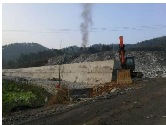
周家隧道出口弃渣场挡墙
