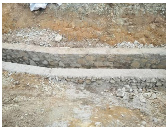
大路下斜井弃渣场排水沟
