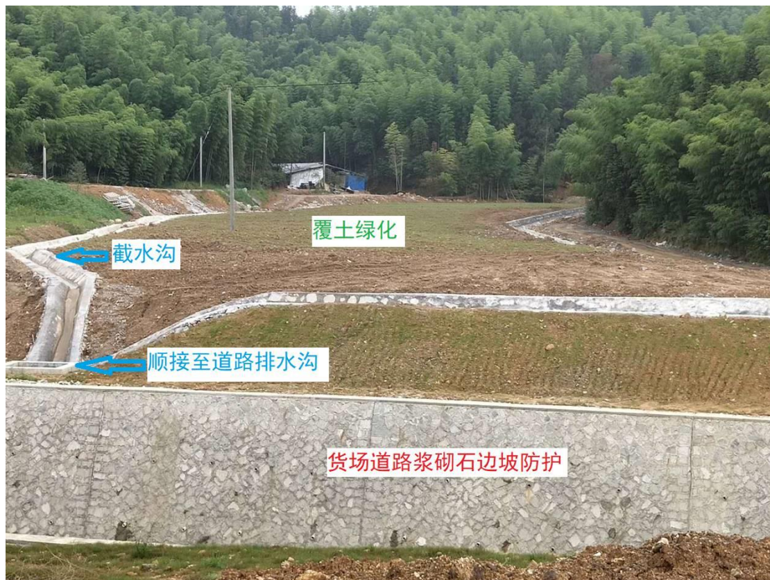
图 2.2.4.1-21 西侧堆渣水土保持措施现状图
