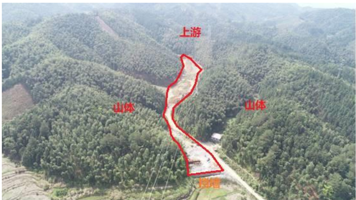
图 2.2.4.1-58 弃渣场航拍现状图（下游拍摄）
