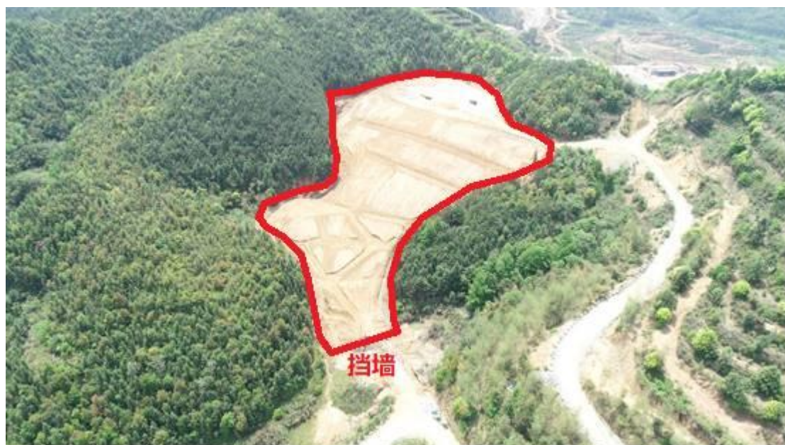
图 2.2.4.1-30 弃土场航拍影像图
