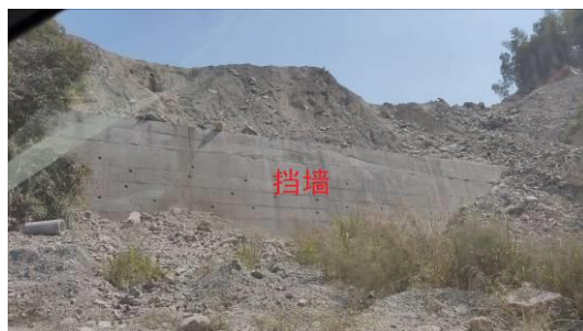
安民隧道出口及平导弃渣场挡墙
