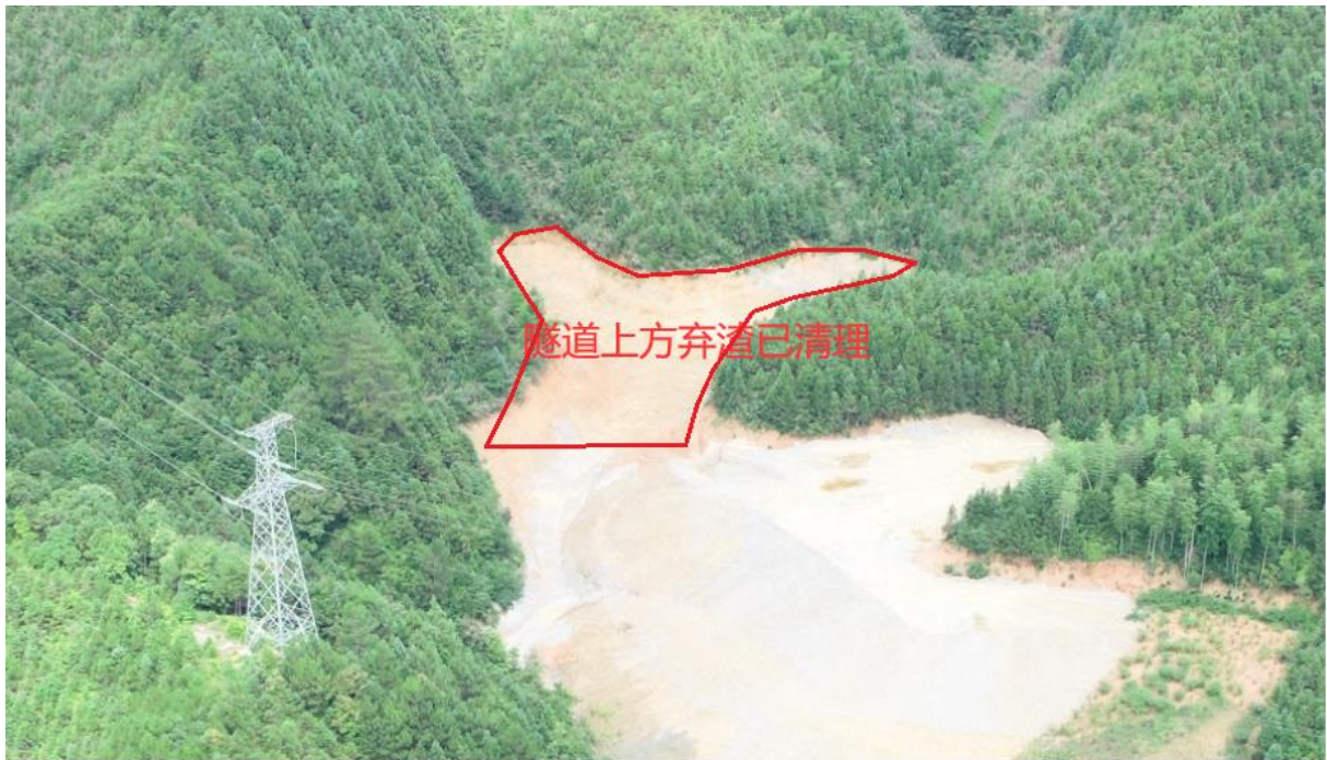
图 2.2.4.1-55 隧道上方弃渣清理后照片
