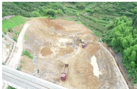
赤津岭隧道弃渣场堆放的表土
