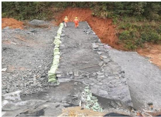
先挡后弃-修建挡墙
