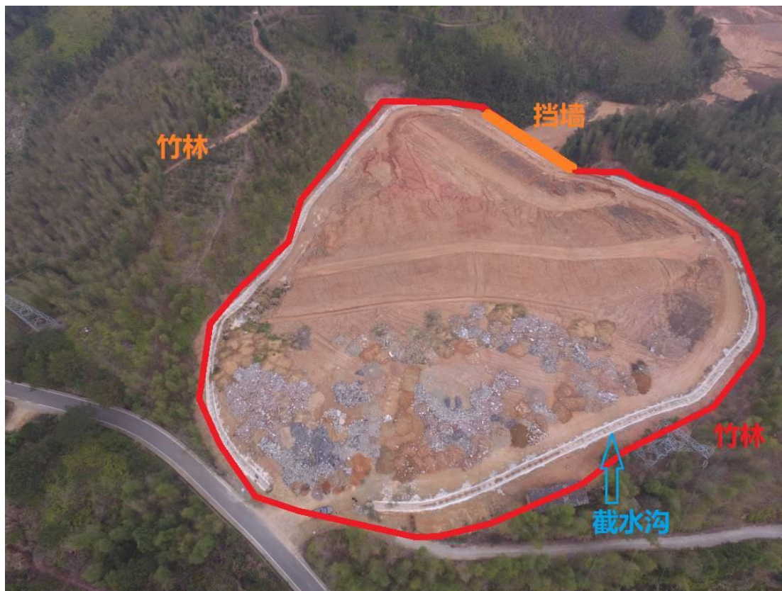
图 2.2.4.1-44 弃土场航拍现状图
