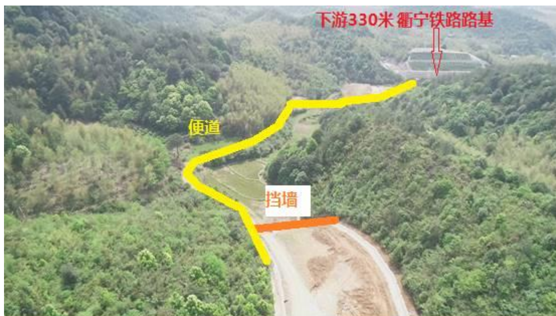
图 2.2.4.1-4 弃渣场下游现状图
