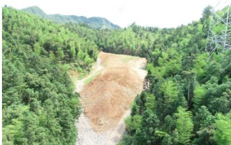
小梅隧道进口弃渣场堆放的表土
