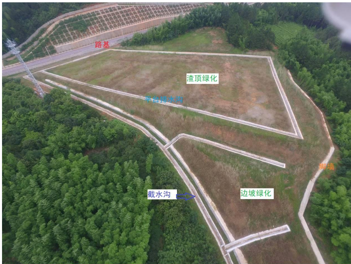
图 2.2.4.1-16 弃土场措施实施情况图
