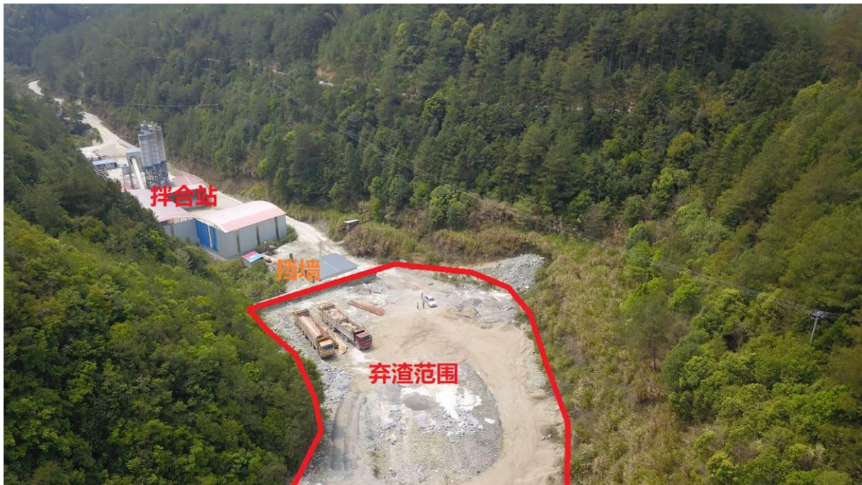
图 2.2.4.1-40 弃渣场下游现状图
