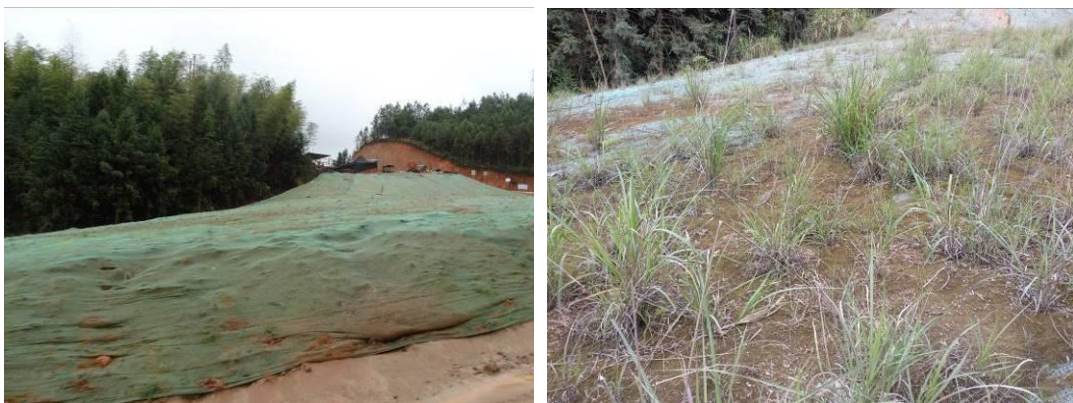
图 4.3.3-1 弃渣场表土临时覆盖现状图（古田弃土场）
