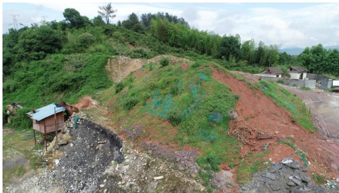
图 4.3.3-2 弃渣场表土临时覆盖现状图（明洞弃渣场）
