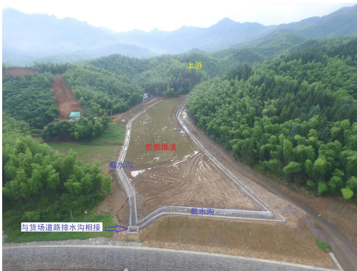
图 2.2.4.1-19 弃土场航拍现状图
