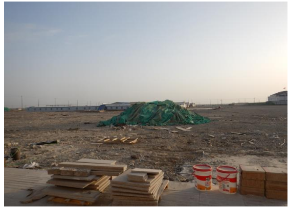
建筑材料临时苫盖
