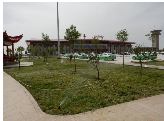
航站区绿化及灌溉措施（二）
