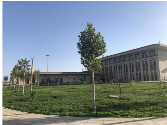
建筑物和道路之间空地绿化（二）
