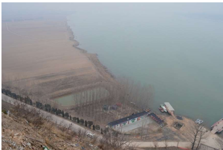
太阳渡工程处坍塌
