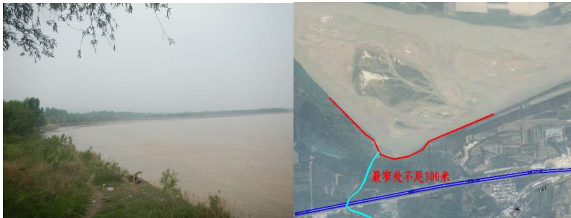
鸡子岭工程上首（双桥河入黄口）
