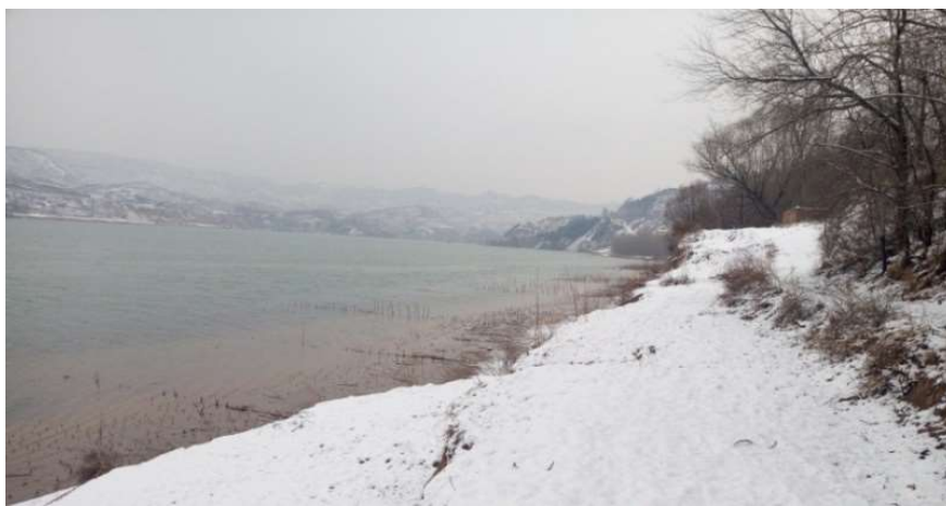
大安工程处坍塌
