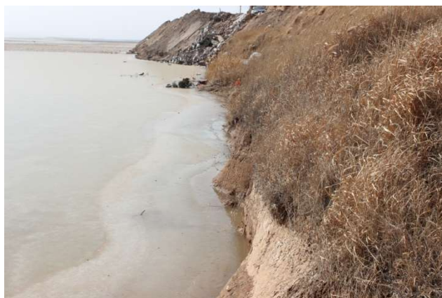
大禹渡工程扬水站处
