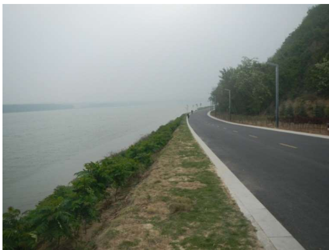
会兴工程处坍塌
