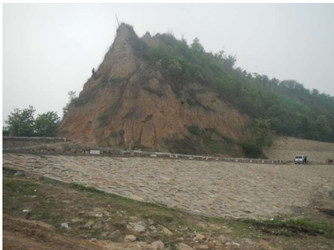
小安工程处坍塌
