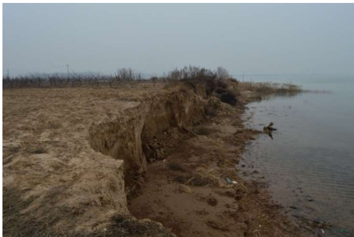
张裕工程处坍塌
