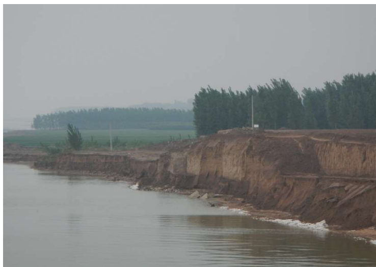
四滩工程处坍塌
