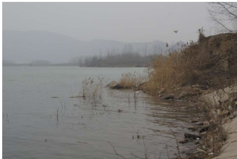
盘南工程处坍塌
