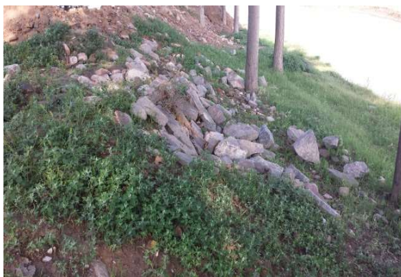
原村加高段工程现状
