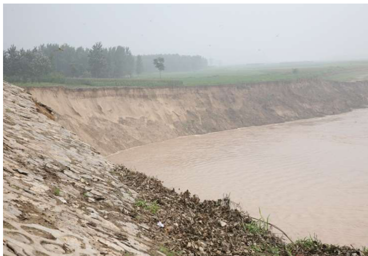
沙口工程处坍塌
