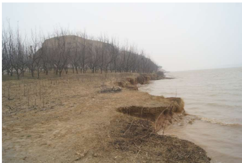
车村工程处坍塌
