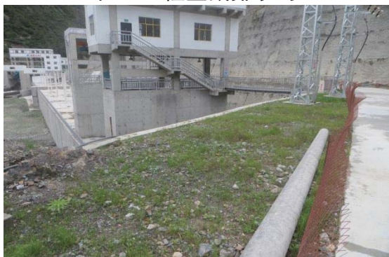
枢纽工程区绿化
