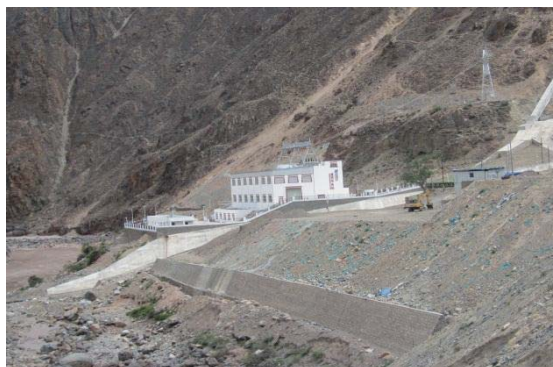
弃渣场挡渣墙
