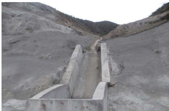
枢纽工程区截排水沟
