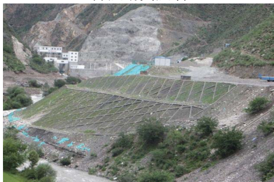
弃渣场边坡绿化
