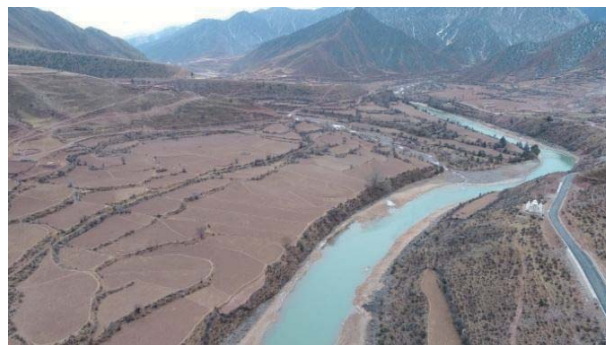
照片 2.2-4 下游施工区
