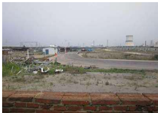
图 2.1-2 取水泵房位置现场照片
