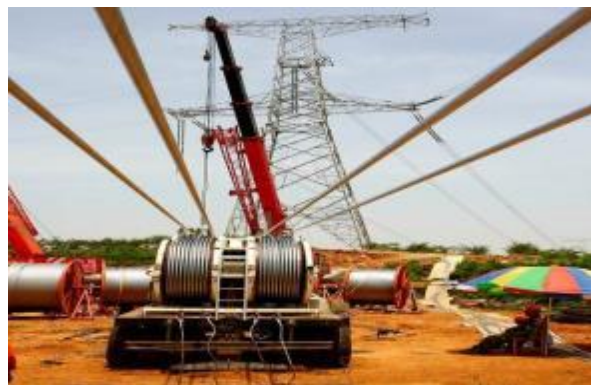
图 2-1 线路工程沿线牵张场布置形式照片
