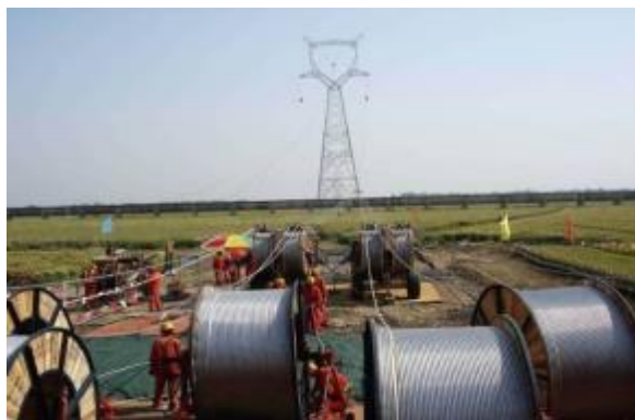
图 2-1 线路工程沿线牵张场布置形式照片
