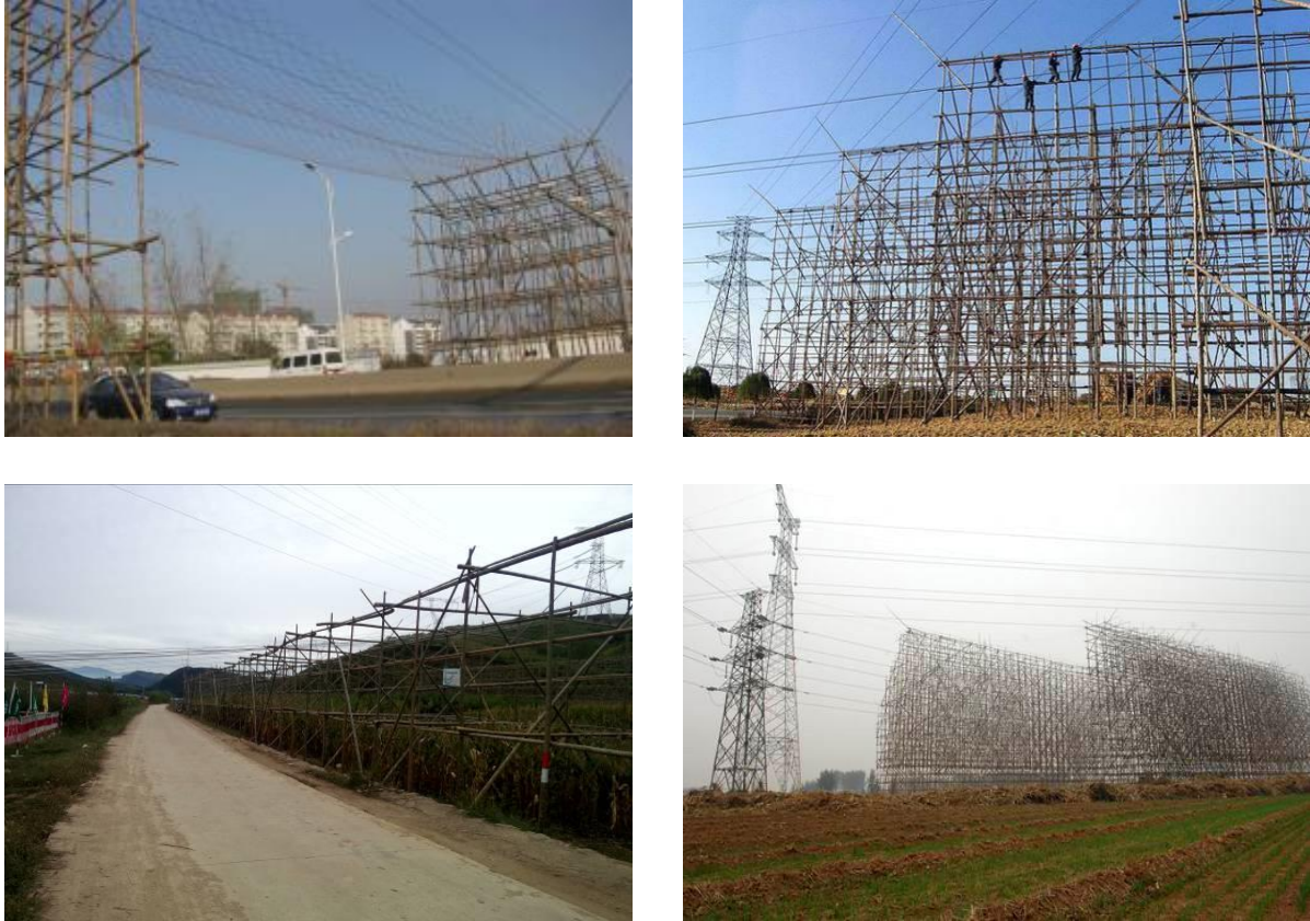
图 2-2 线路工程临时跨越形式照片
