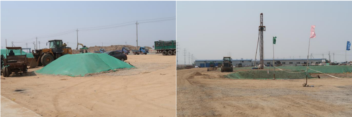
临时苫盖（接收站）
