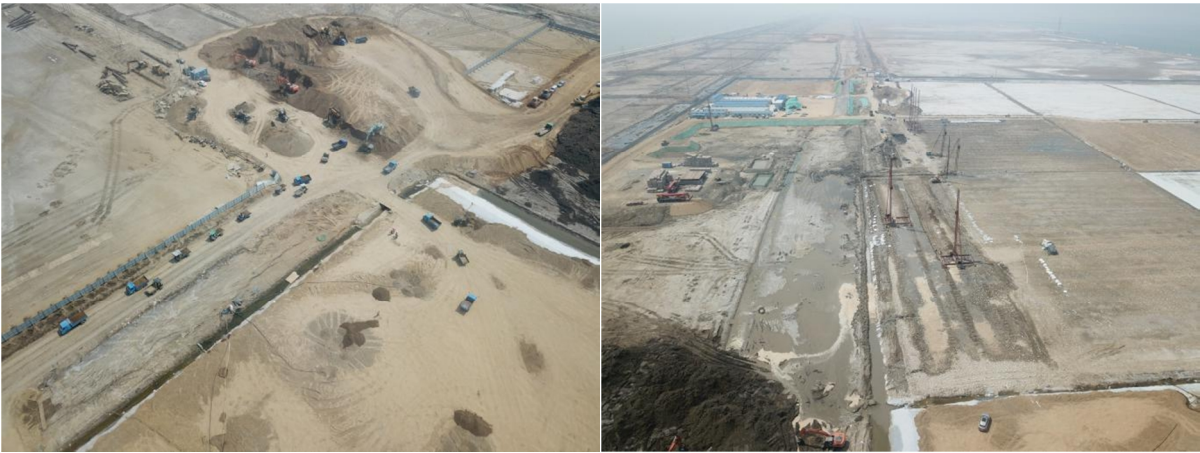
临时排水沟（接收站）
