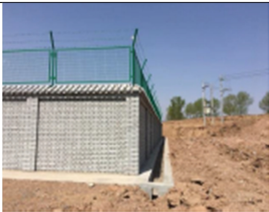
阀室外排水沟
