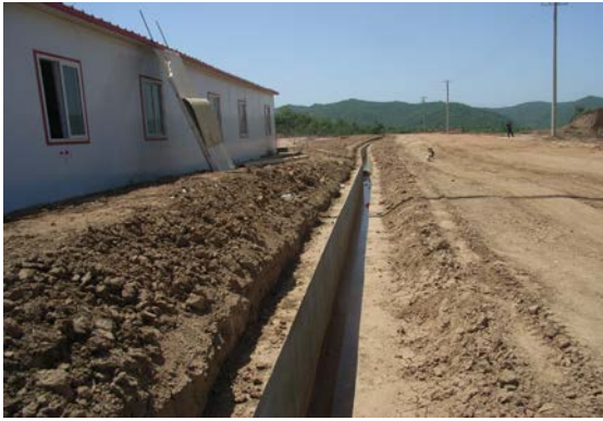
工业场地内混凝土排水沟
