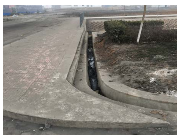
进场道路的排水沟
