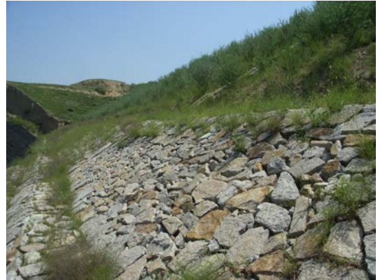
拦渣坝干砌石护坡
