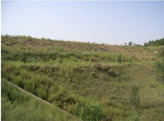
矸石周转场拦渣坝及植物护坡
