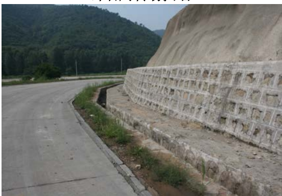
道路排水沟及边坡防护
