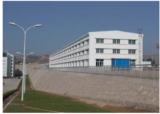
工业场地内浆砌石护坡及绿化
